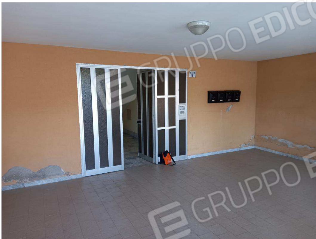
Foto 3 – Portone di ingresso
