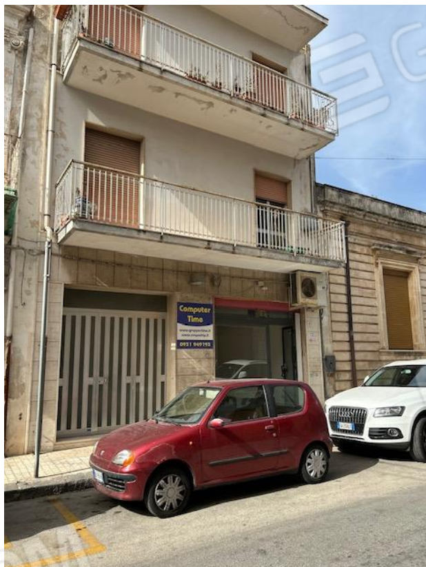
VISTA 1_ Prospetto intero stabile
