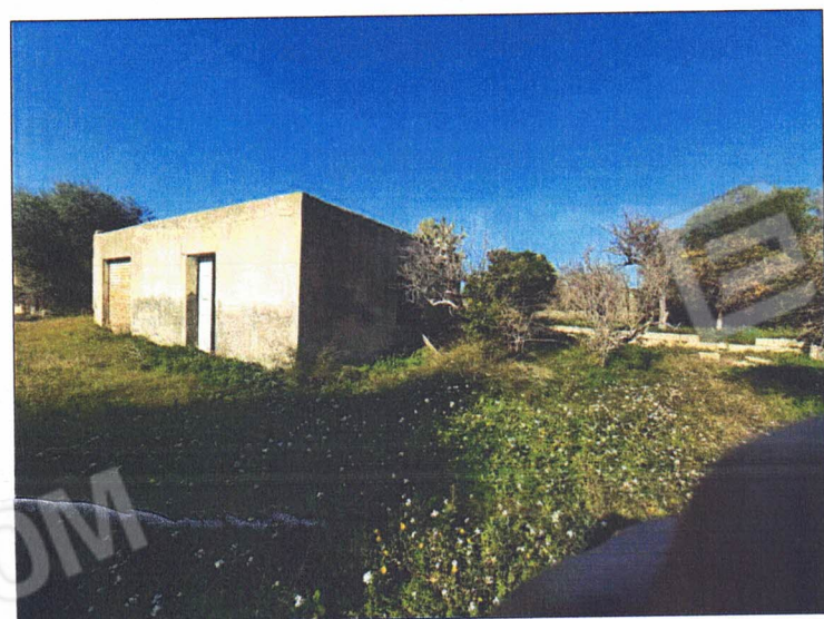
Foto 15-16 - Foto dei prospetti del deposito non in buono stato conservativo. Si accede a mezzo di porta garage e portone. E' presente un ambiente esterno destinato a forno.
