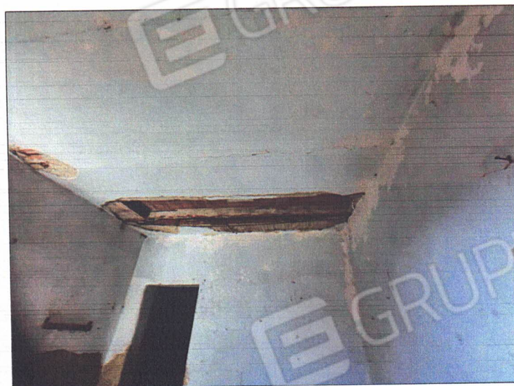
Foto 17-18 - Viste del deposito 1 in pessimo stato conservativo con solai misti e pareti in muratura danneggiati da infiltrazioni di acqua e umidità.
