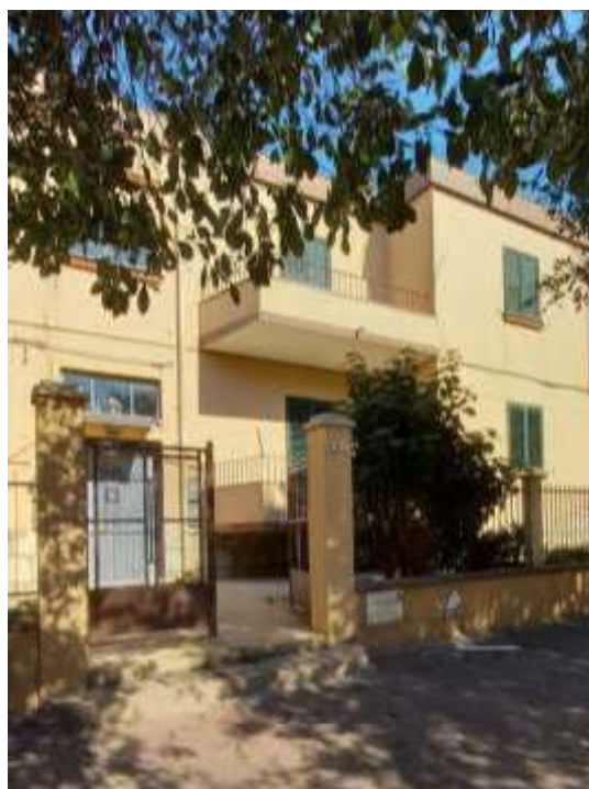
Foto 1 – Immobilе “1A” – Appartamento al piano terra-rialzato in via G. Pascoli, prospetto sud
