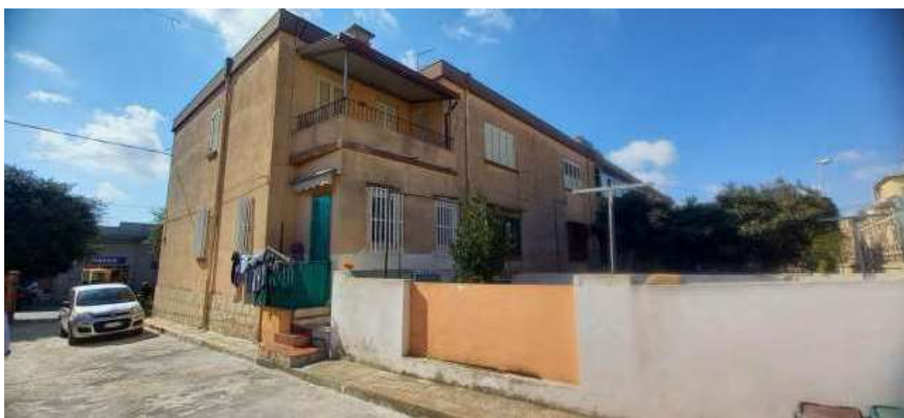
Foto 5 – Immobile “1A” – Appartamento al piano terra-rialzato in via Calabria, prospetto retrostante
