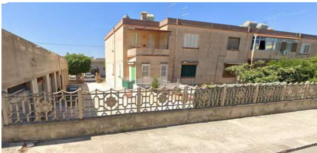
Foto 4 – Immobile “1A” – Appartamento al piano terra-rialzato in via Calabria, prospetto retrostante
