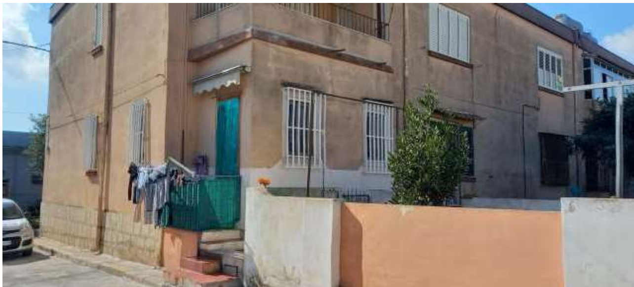
Foto 6 – Immobile “1A” – Appartamento al piano terra-rialzato in via Calabria, prospetto retrostante
