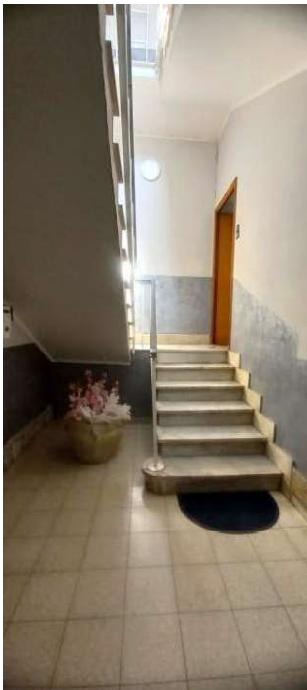
Foto 7 – Immobile “1A” – Ingresso del condominio
