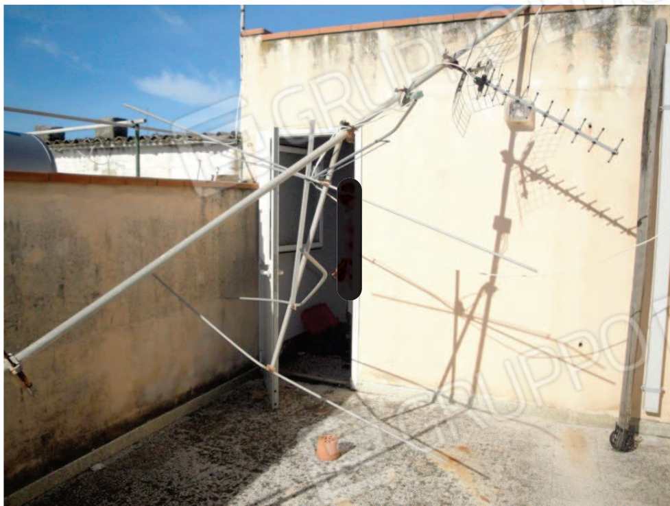
foto 11_ veduta esterna del terrazzino
