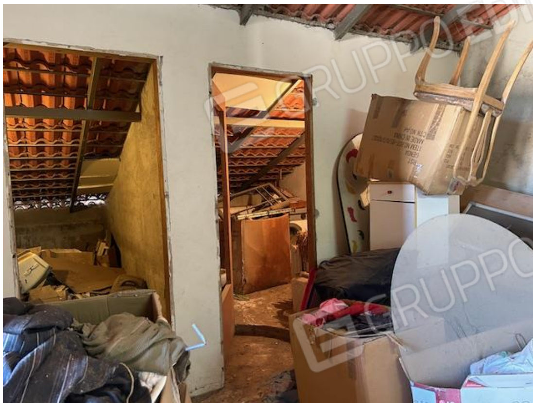
VISTE 12-13-14_Interni Locali sgombero 2°P
