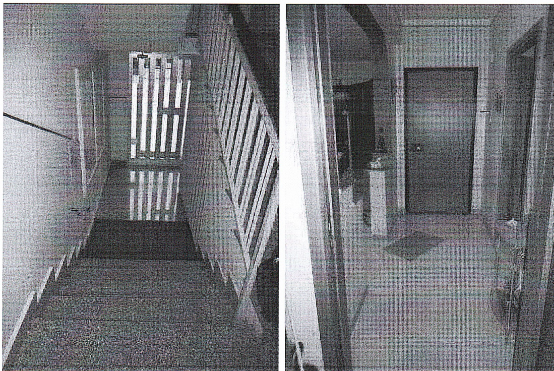
Figura 7: corpo scala ed ingresso appartamento
