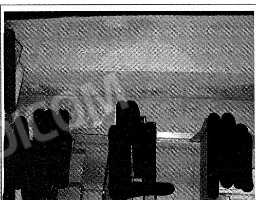
28. Interno vano negozio dell'unità immobiliare al piano terra, in foto degrado dello strato di intonaco avvenuto rispetto al sopralluogo del 2017.
