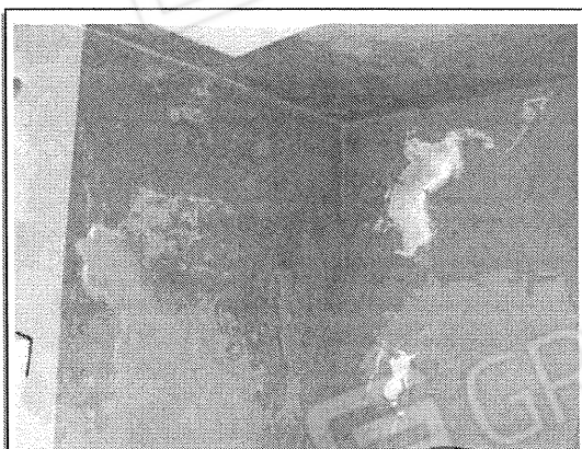
27. Interno vano negozio dell'unità immobiliare al piano terra, in foto degrado dello strato di intonaco avvenuto rispetto al sopralluogo del 2017.
