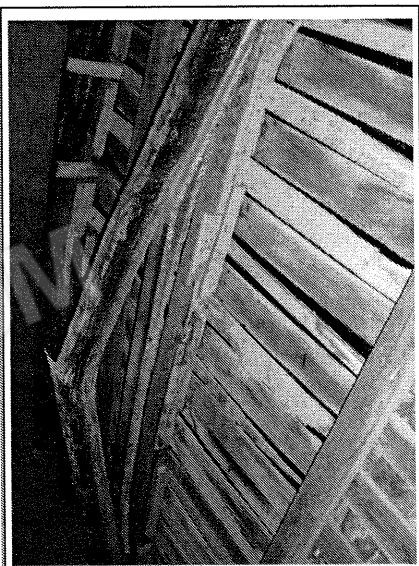
48. Interno piano sottotetto dell'unità immobiliare, vista lato sud-est, in foto particolare sul tetto ligneo in pessimo stato manutentivo con travi fortemente compromesse nella loro stabilità strutturale.
