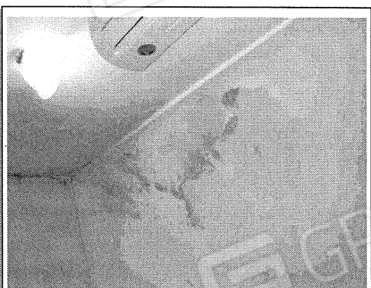
31. Interno vano ufficio dell'u. i. al p. I sub. 3 e 4 graffite, in foto degrado dello strato di intonaco avvenuto rispetto al sopralluogo del 2017.
