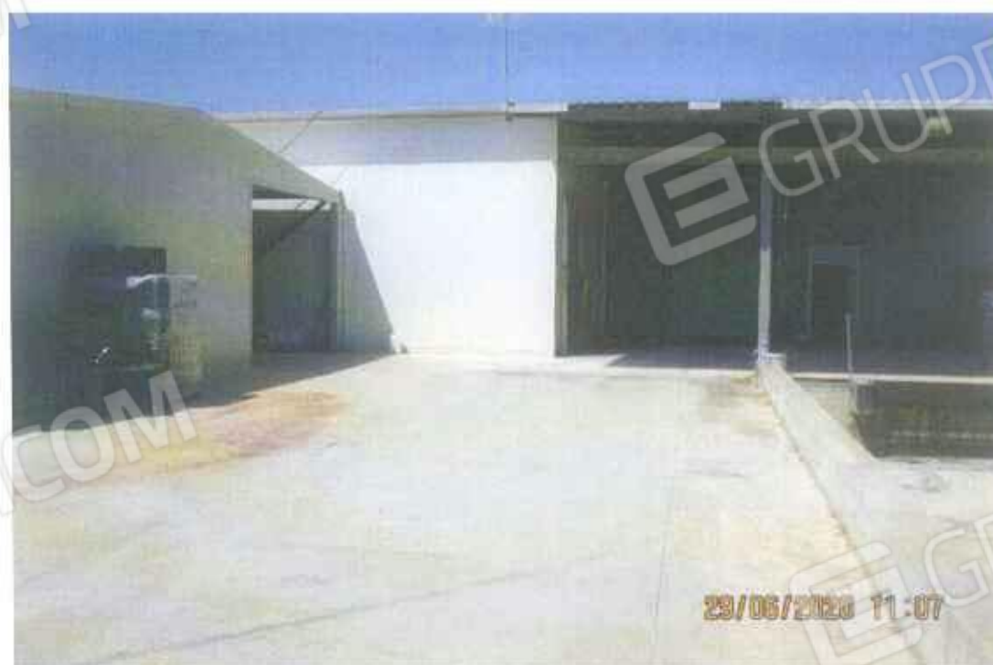
Foto 22: i tre capannoni visti dall'esterno e la tettoia da demolire
