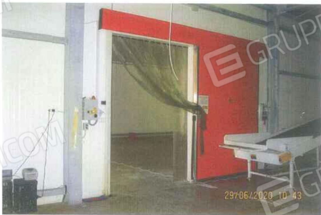
Foto 14: accesso al capannone adiacente dall'interno.
