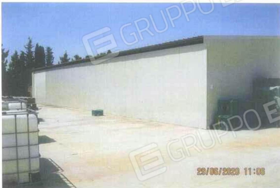
Foto 21: il terzo capannone visto dall'esterno
