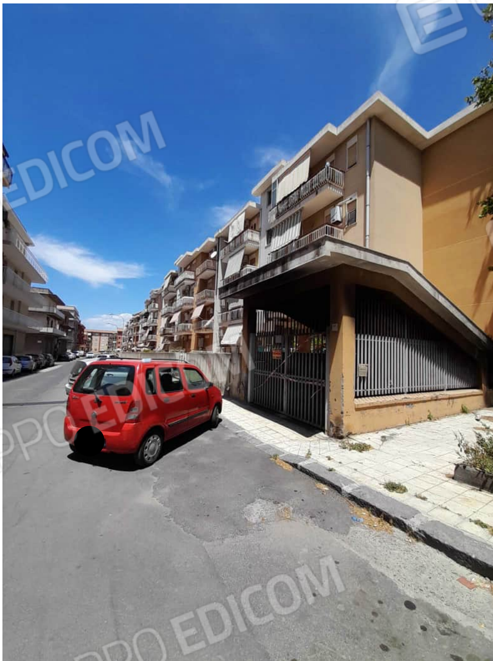
Foto n°19 - vista dell'accesso all'autorimessa sottostrada dal civico 16
