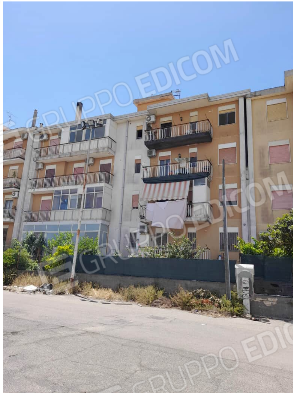
Foto n°2 - vista del prospetto posteriore su strada privata
