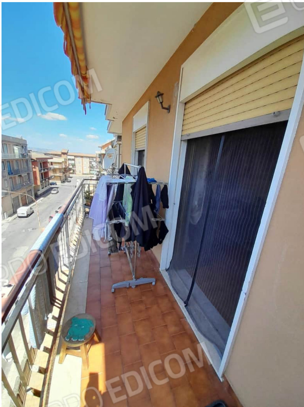
Foto n°11 - vista del balcone grande su via Gela
