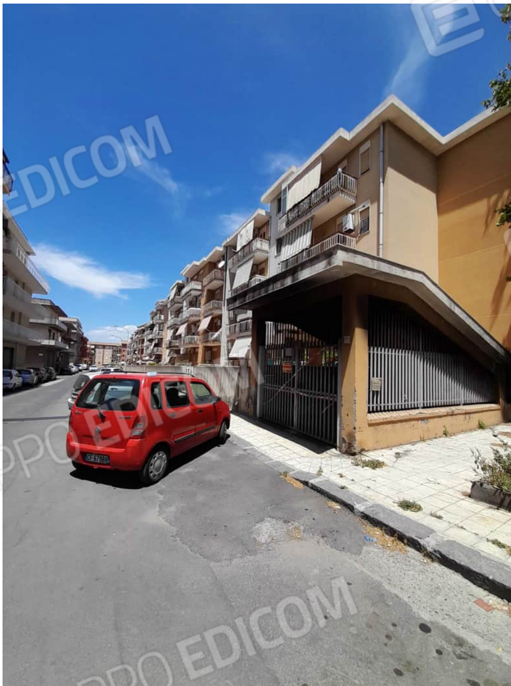
Foto n°19 - vista dell'accesso all'autorimessa sottostrada dal civico 16
