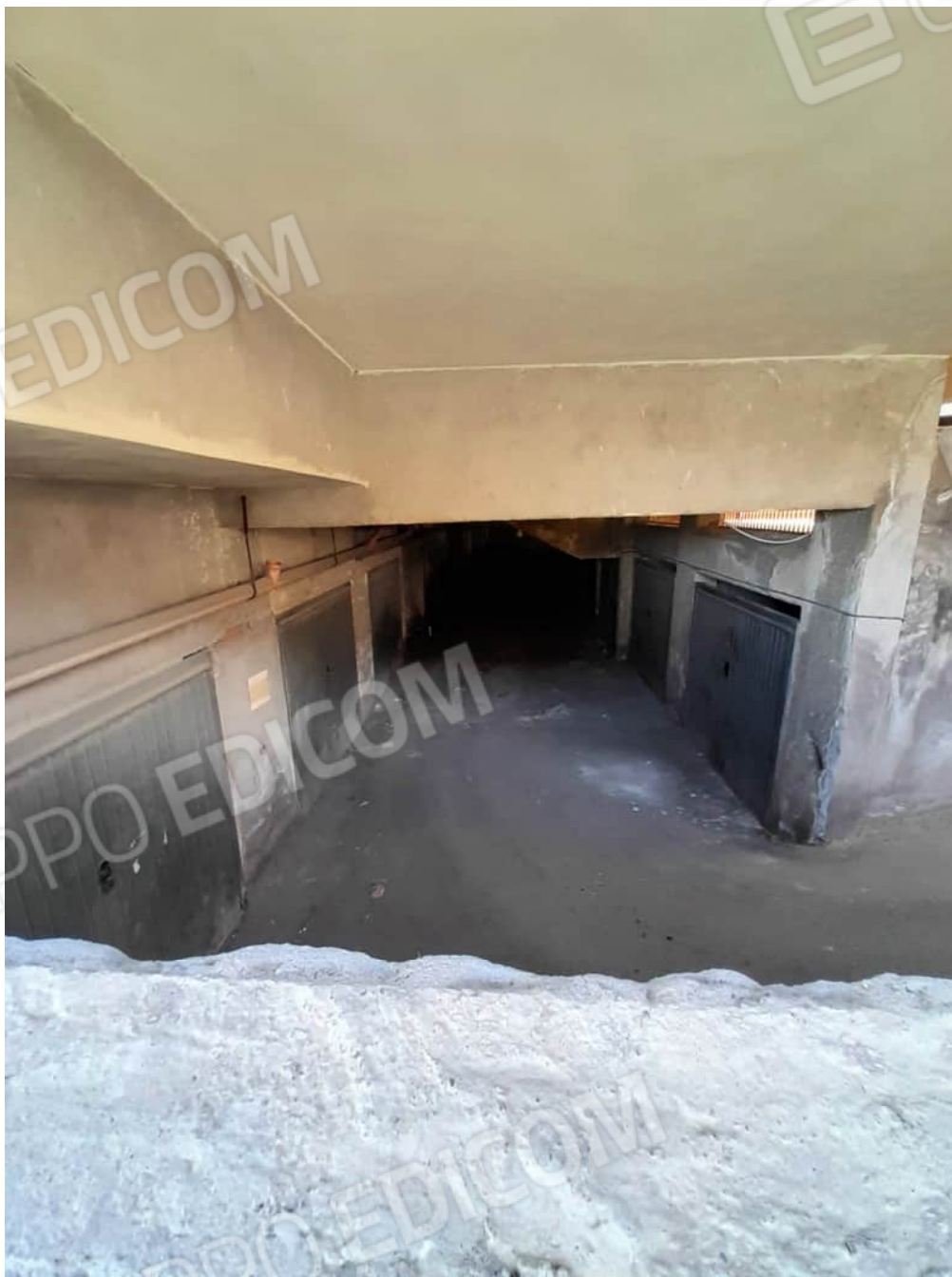
Foto n°21 - vista della corsia di manovra comune
