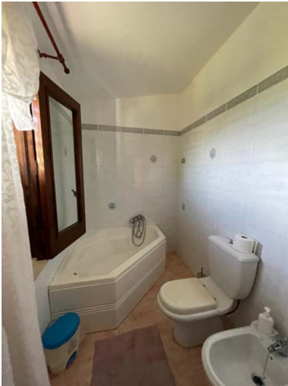
Vista del servizio igienico a piano primo
