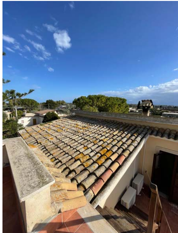
Vista esterna delle coperture
