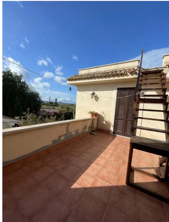
Vista della terrazza 02 a piano primo
