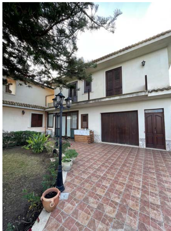
Vista esterna dell'immobile
