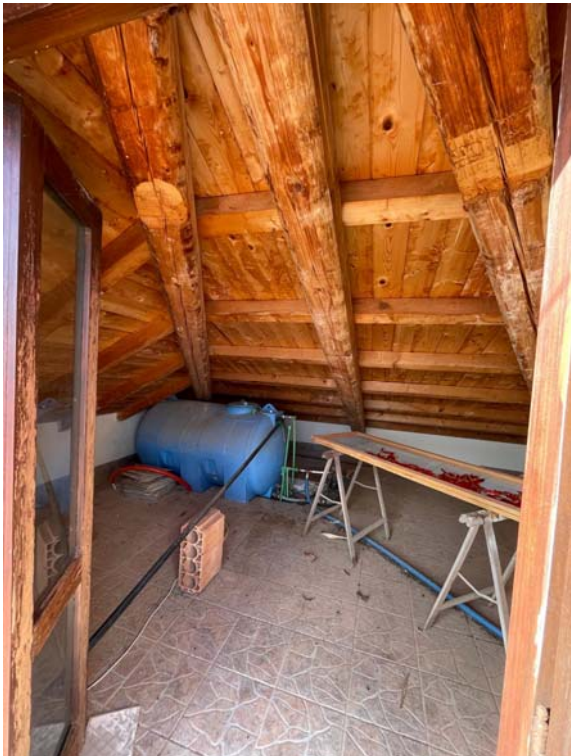
Vista del sottotetto tecnico di copertura
