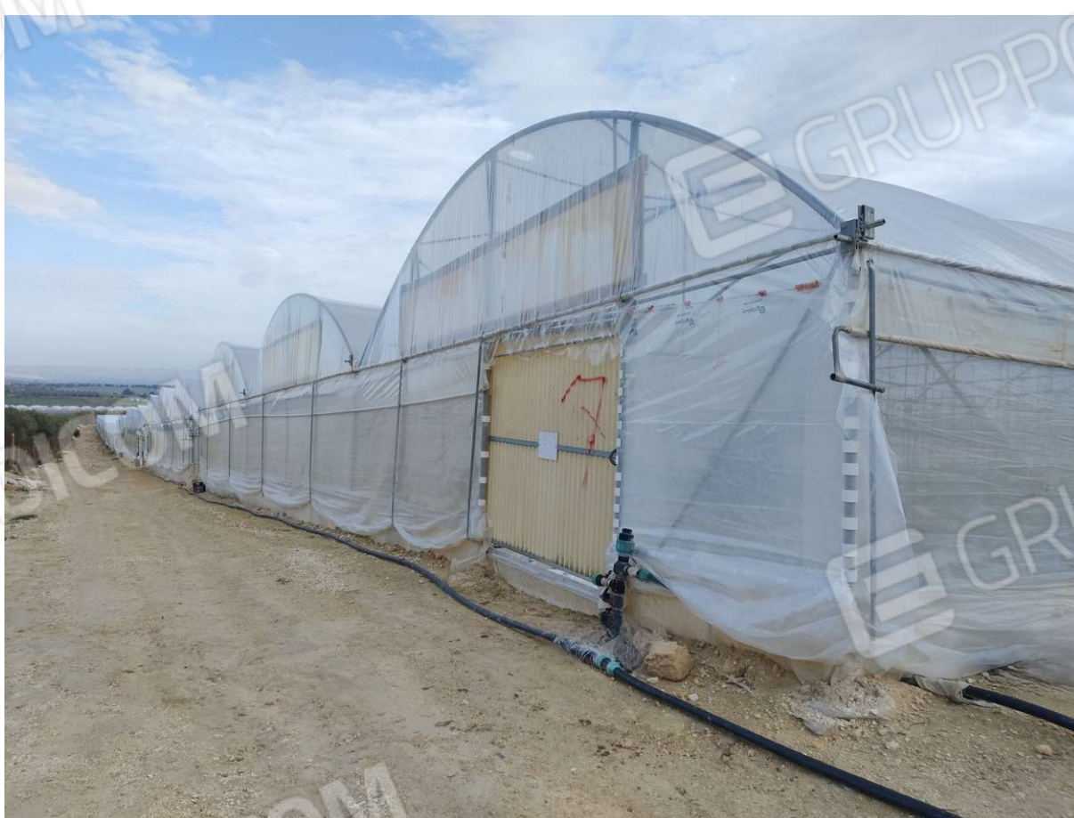
Foto 14 e 15 – Serre metalliche e particolari costruttivi.
