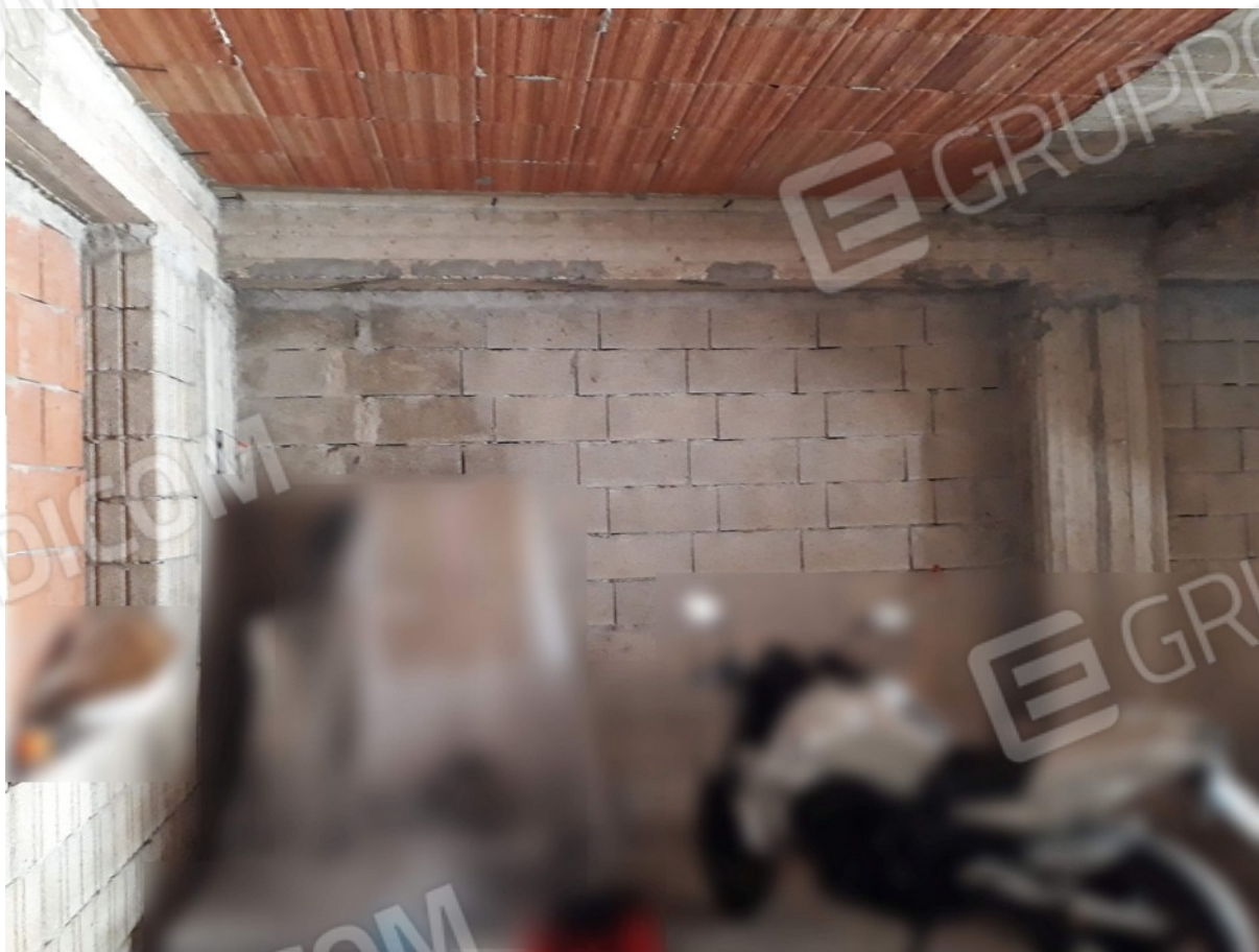
Foto 4 e 5 – Interno del garage (bene B).
