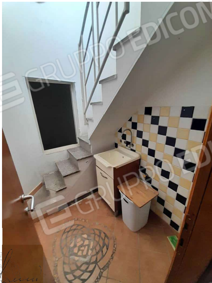
Foto n°10 - Vista interna del pozzo luce/lavanderia
