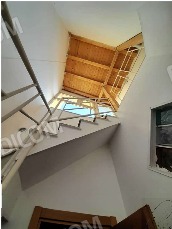
Foto n°11 - Vista interna del pozzo luce
