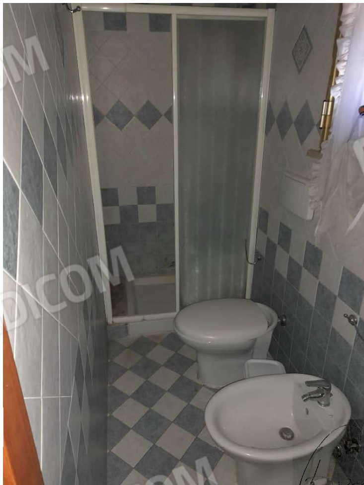
Foto n°9 - Vista interna del bagno
