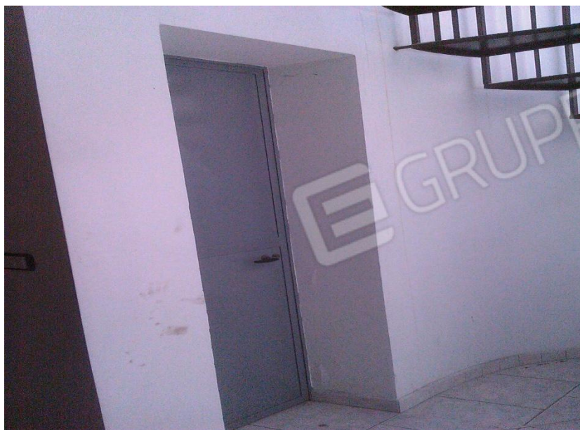
Uscita esterna verso l' oblò che porta alle scale del condominio
