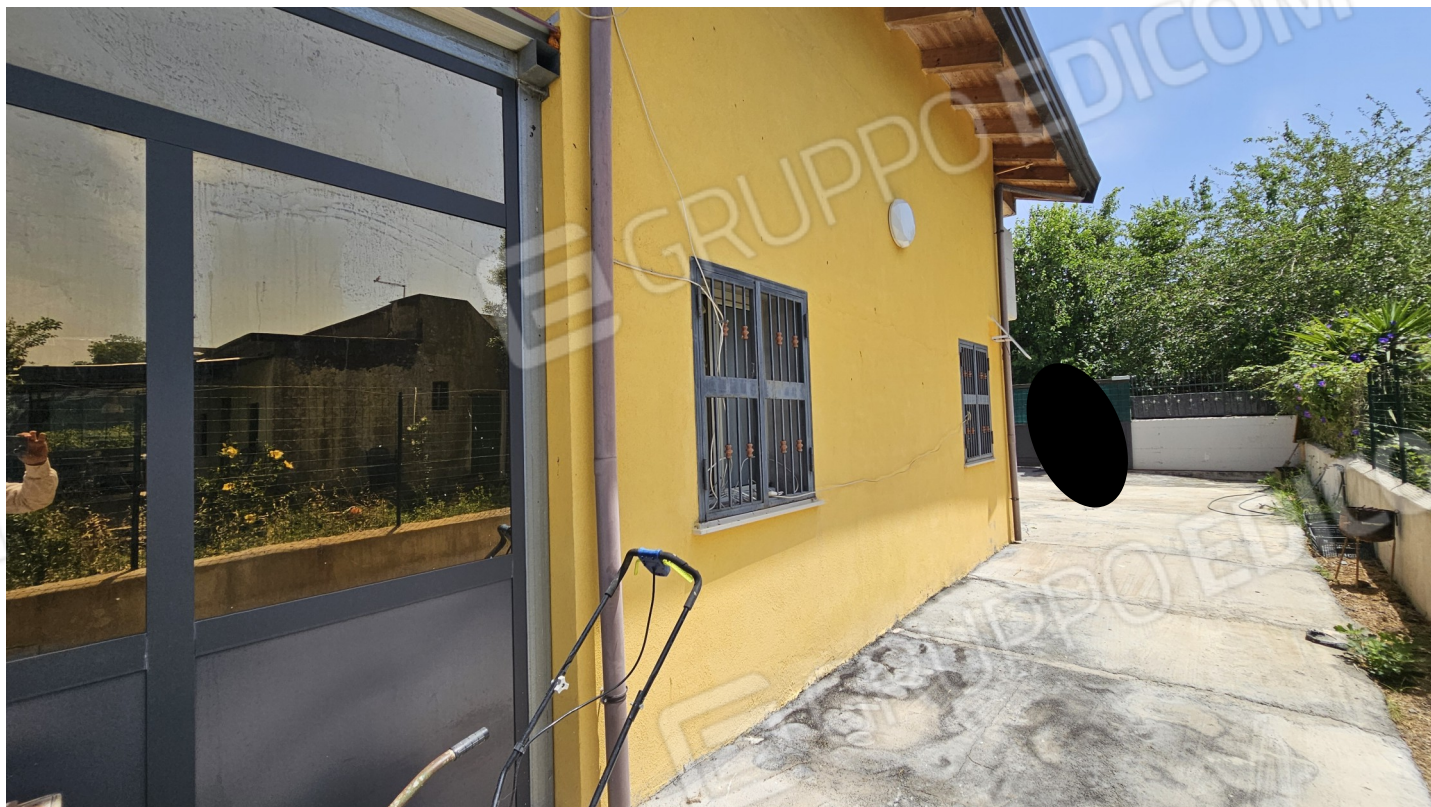
Foto 03 — Vista prospetto laterale lato nord-ovest
