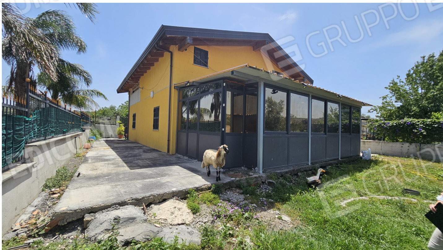
Foto 04 — Vista del prospetto laterale lato nord-est
