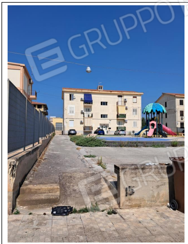
01. Edificio residenziale, con affaccio su area adibita a parco giochi, con ingresso da via Gabriele D'Annunzio. Esposizione lato Est.
