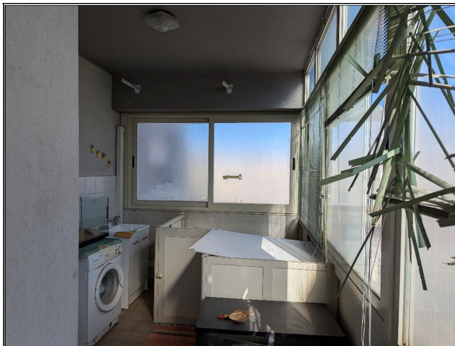
Foto n° 12 – Ballatoio 1 chiuso con struttura metallica
