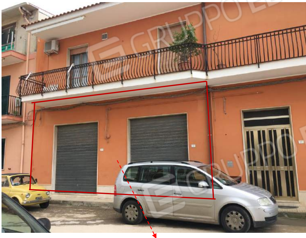
Foto n. 3 – Edificio di via dei Fiordalisi, Cassibile
