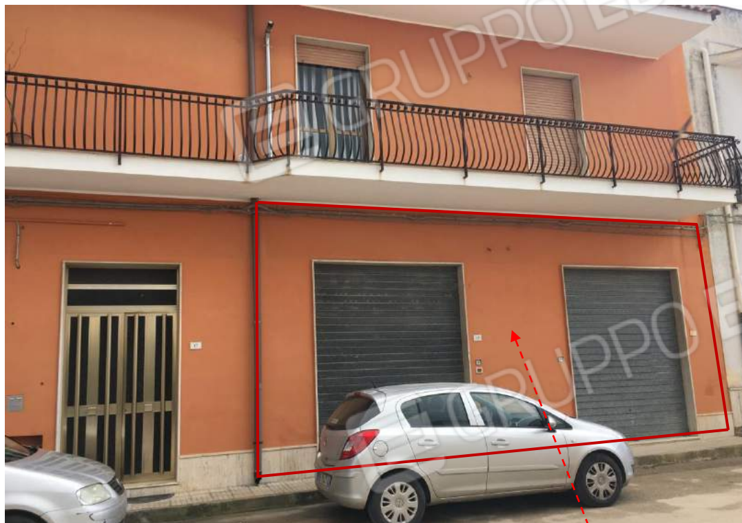
Foto n. 3 – Edificio di via dei Fiordalisi, Cassibile
