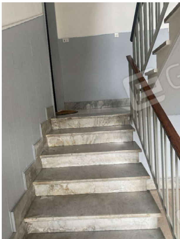
Foto 5: Vista porzione di scala condominiale
