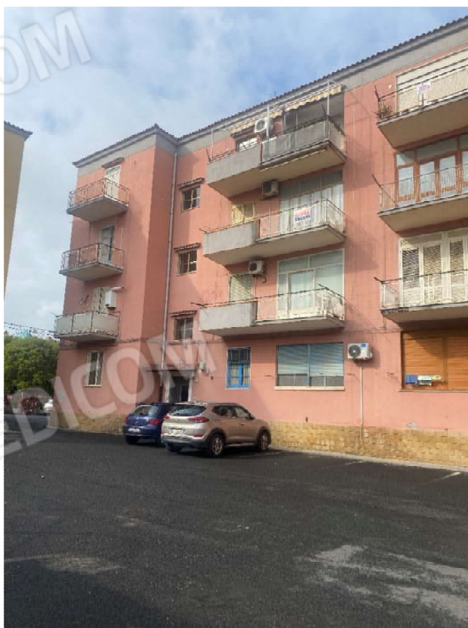
Foto 2: Vista prospetto principale
