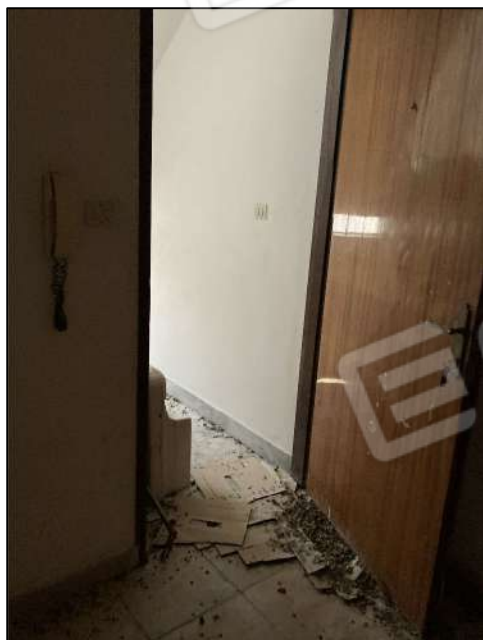
Foto n. 13 : vista ingresso 1 a piano primo
