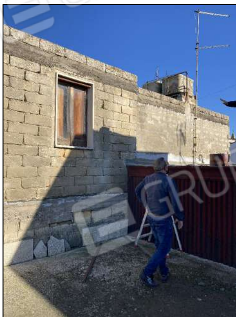
Foto 16 : vista finestra camera 3 a piano 3° .
