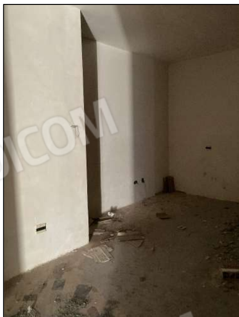
Foto 7 : vista vano privo di tramezzi
