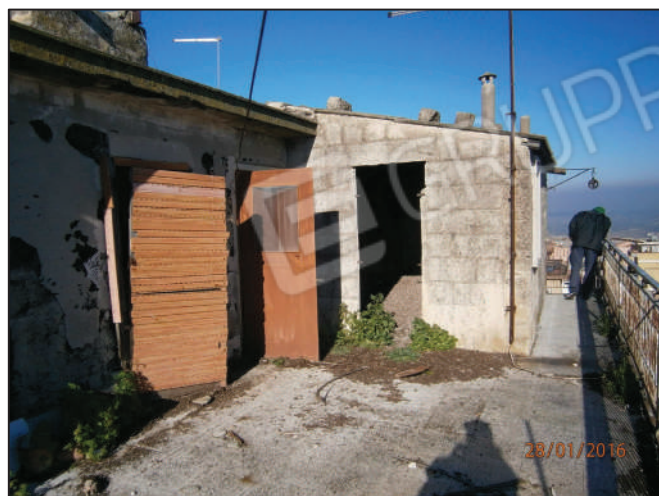
Foto 24 : terrazzo di copertura con vano forno
