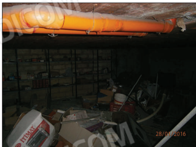
Foto 28: interno del vano garage
