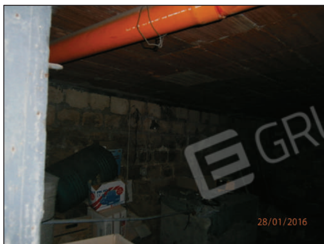
Foto 25 : interno vano garage
