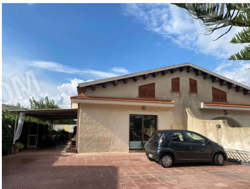
Foto 4: Vista prospetto principale esposto a Est, si fa notare che le finestre al piano sottotetto sono difformi rispetto ai prospetti approvati con C.E. in Sanatoria n° 161/2000, gli stessi non sono regolarizzabili e pertanto da murare, anche la tettoia sulla sx non è regolare né regolarizzabile e pertanto se ne prevede la demolizione.
