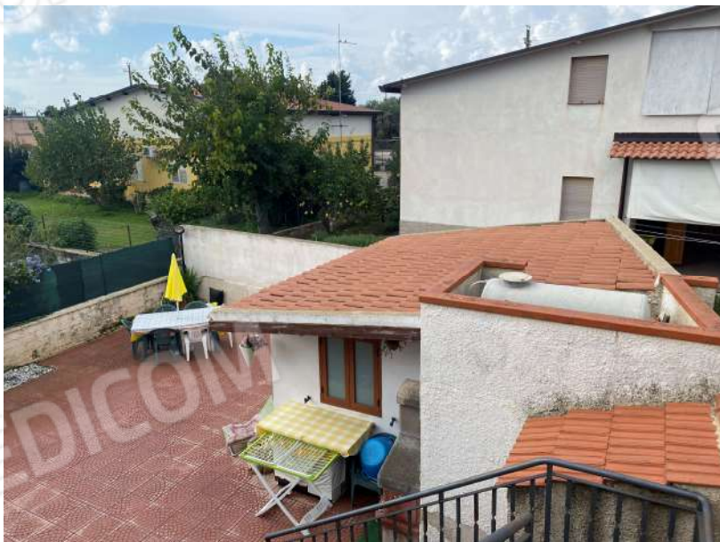
Foto 6: Vista dependance e bagno esterno realizzati in assenza di provvedimenti autorizzativi, non regolarizzabili e pertanto da demolire e vista area esterna di pertinenza sul retro.
