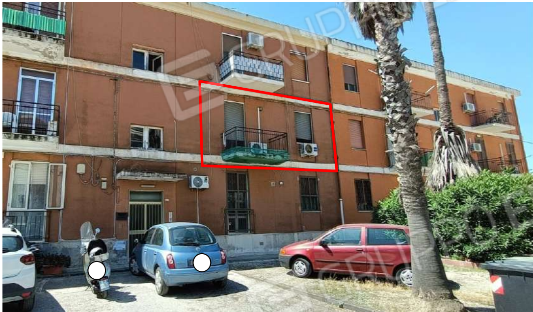
Foto 1. Vista esterna del complesso condominiale.
