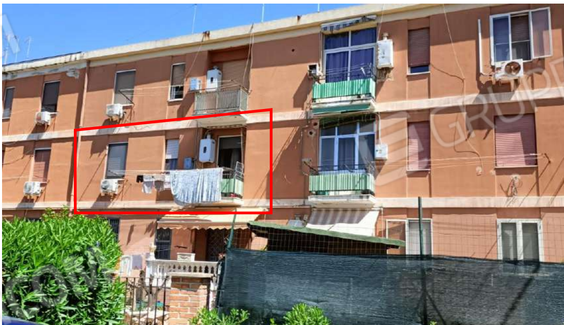
Foto 2. Vista dell'area condominiale della scala H.
