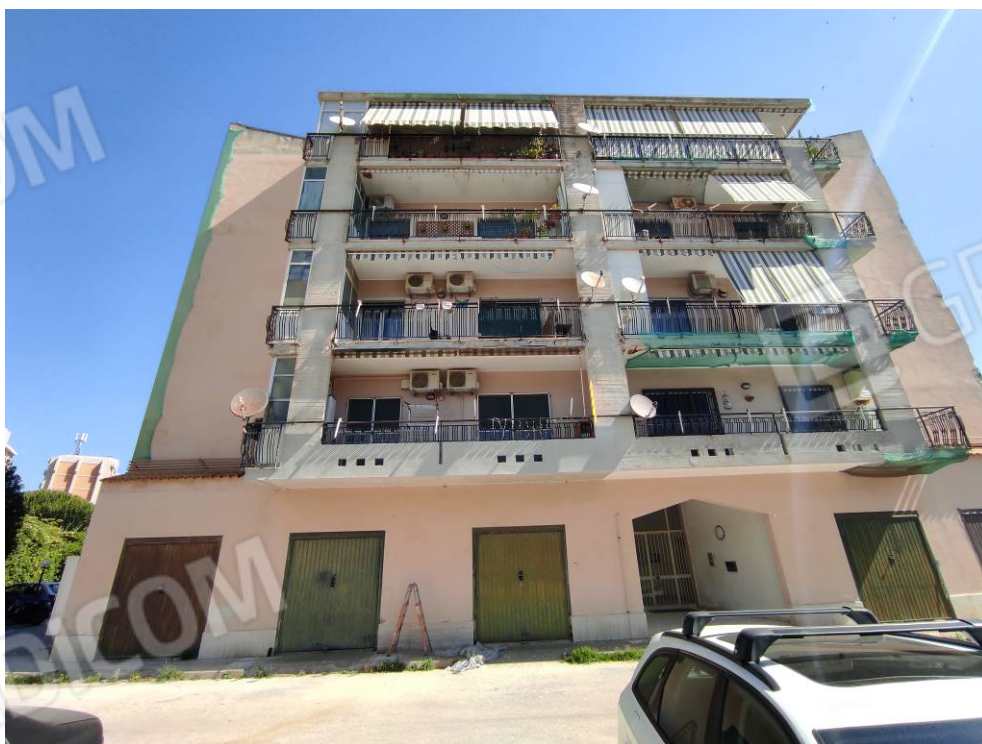
Foto 2 – Prospetto Sud edificio condominiale
