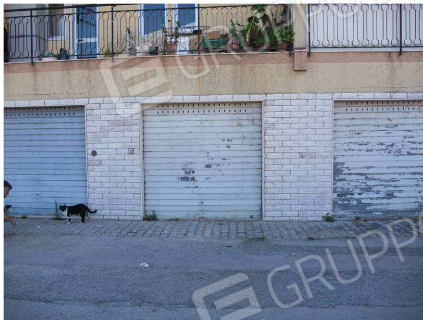
FOTO 9 – infisso esterno garage
