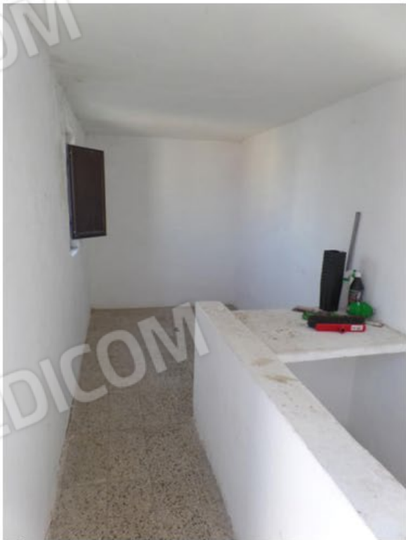
Foto n° 15. P. 2°, Vano Scala
