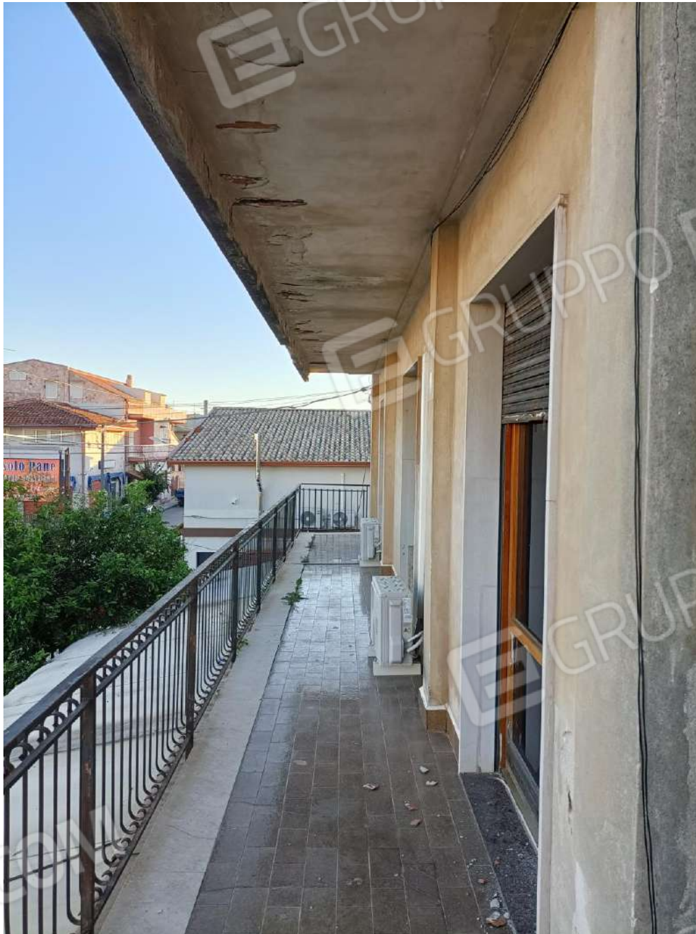
Foto 9. Vista del balcone sul lato est.
