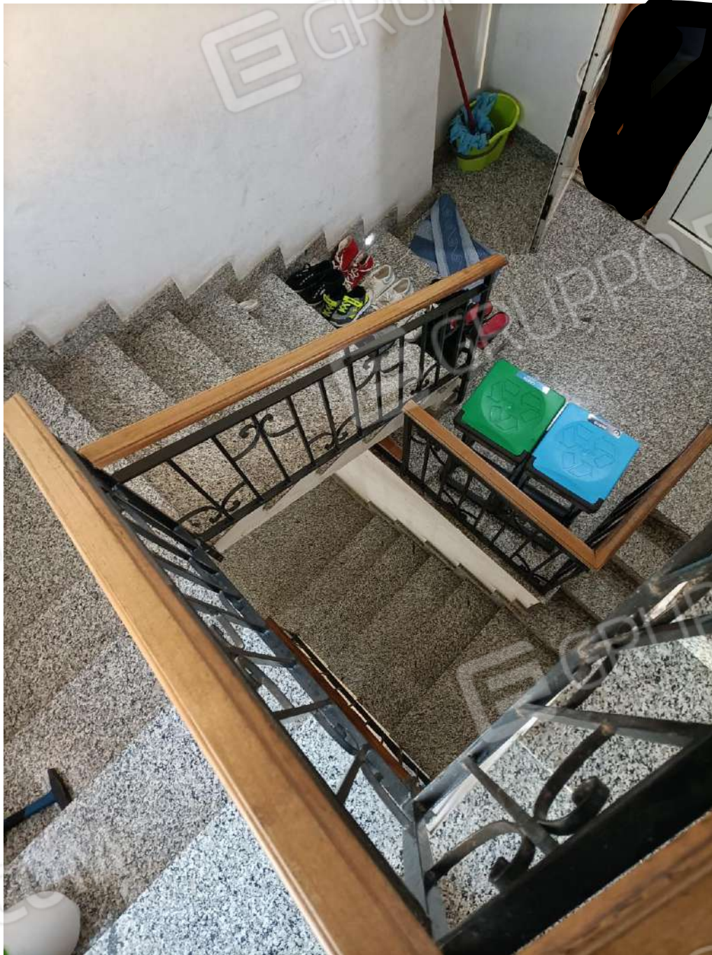
Foto 11. Vista dall'alto del vano scala.
