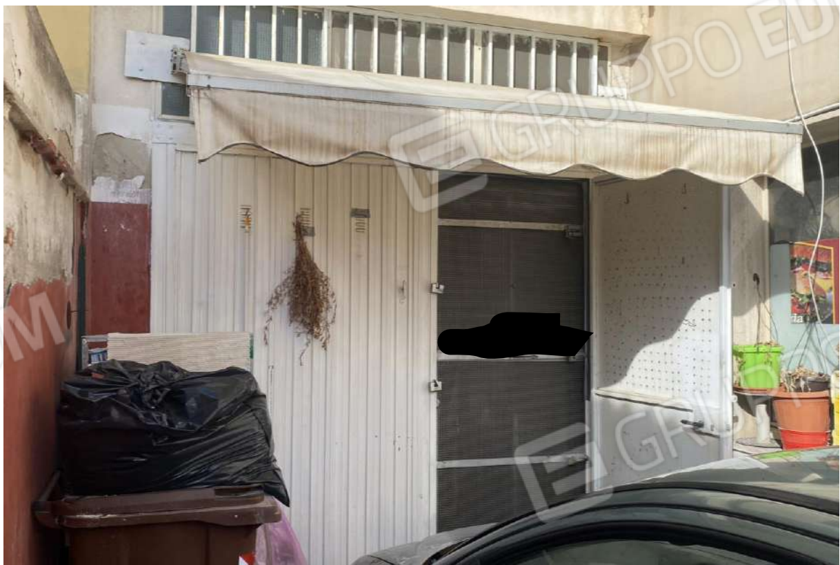
Foto 1. Vista esterna del garage.
