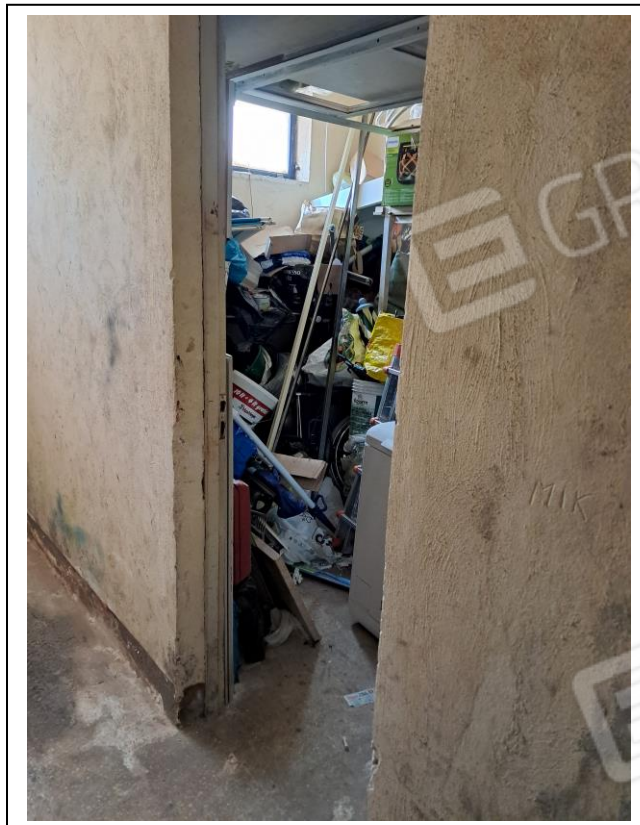
34. Porta di accesso al ripostiglio al p.t. annesso all'u.i. con vista verso lato ovest, presenza di piccola finestra con apertura a vasistas.
