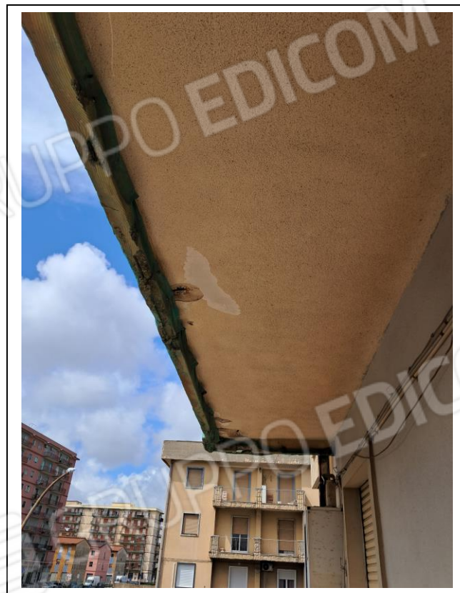
24. Esterno dell'unità immobiliare con vista verso lato S-O, in foto parte dell'intradosso del balcone sovrastante in cattivo stato di manutenzione.
