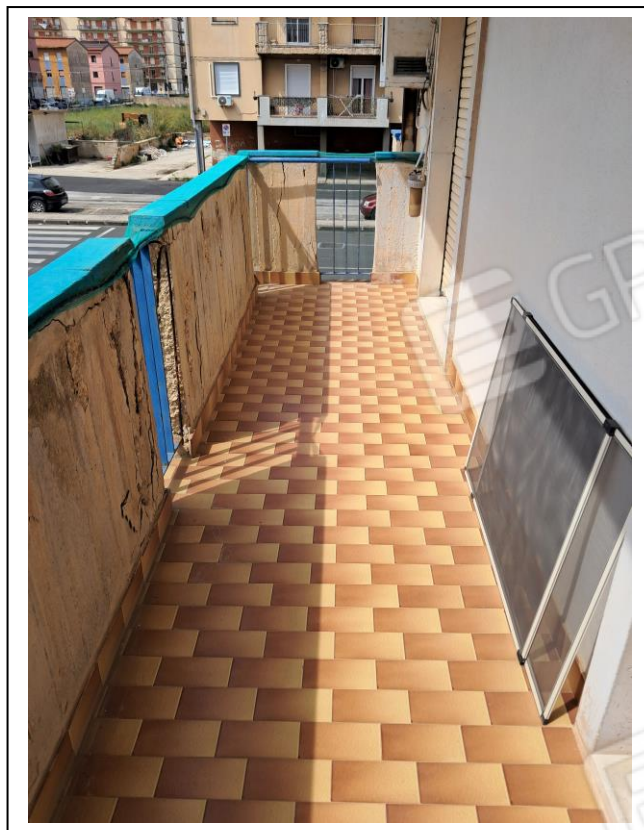
23. Esterno dell'unità immobiliare con vista verso lato S-O, in foto balcone in aggetto in cattivo stato di manutenzione.
