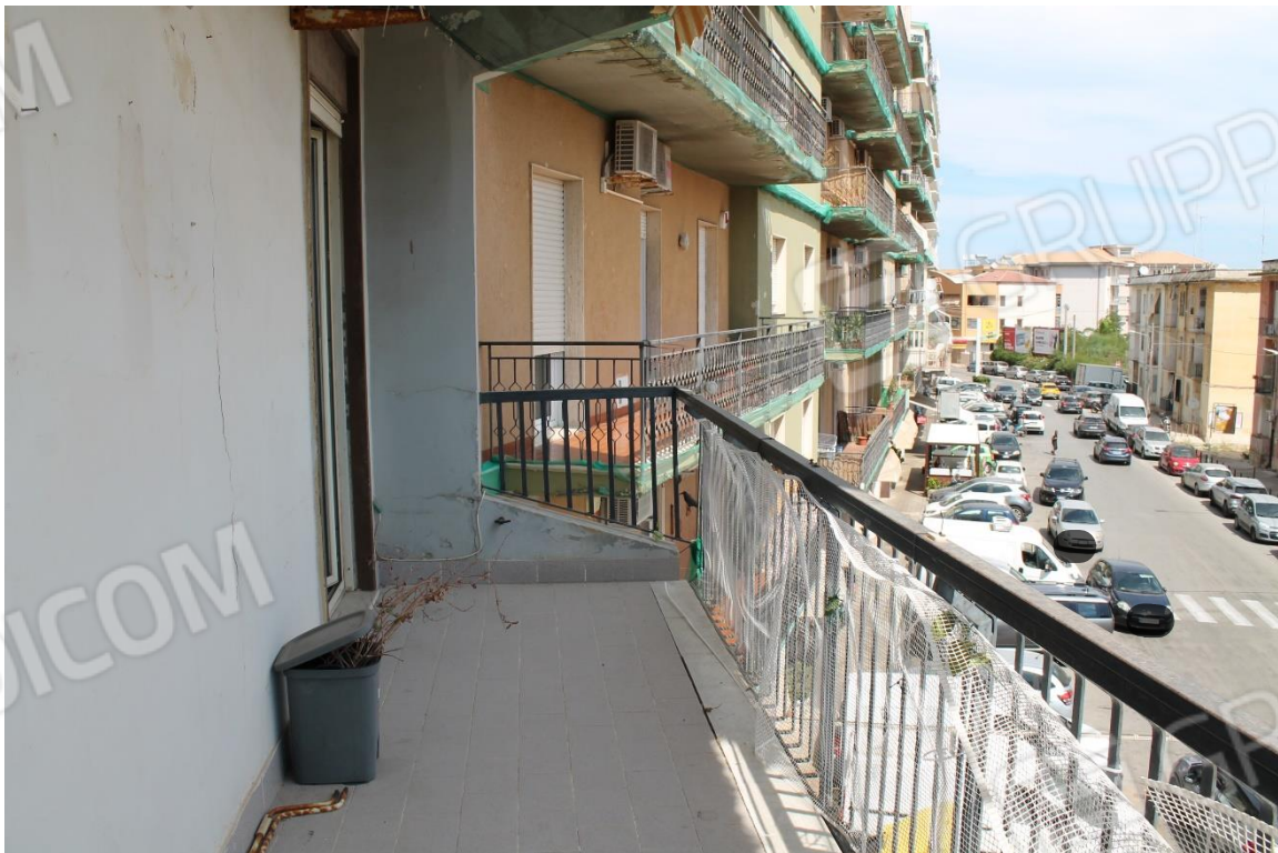
Balcone su Via Grottasanta
