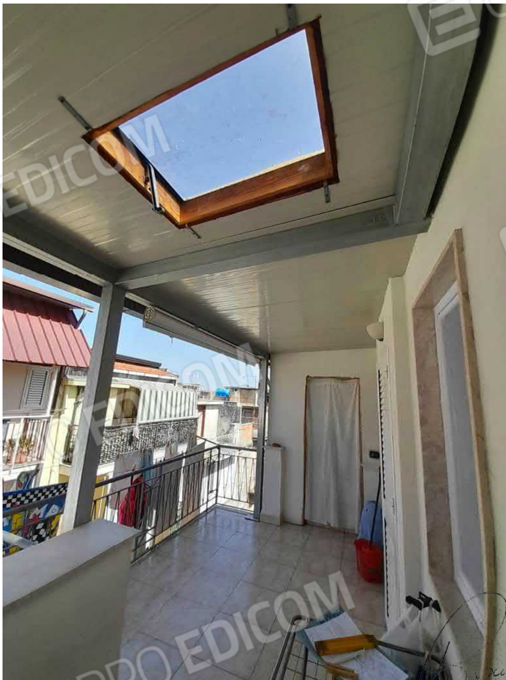
Foto n°11 - Vista della veranda coperta al 3° piano
