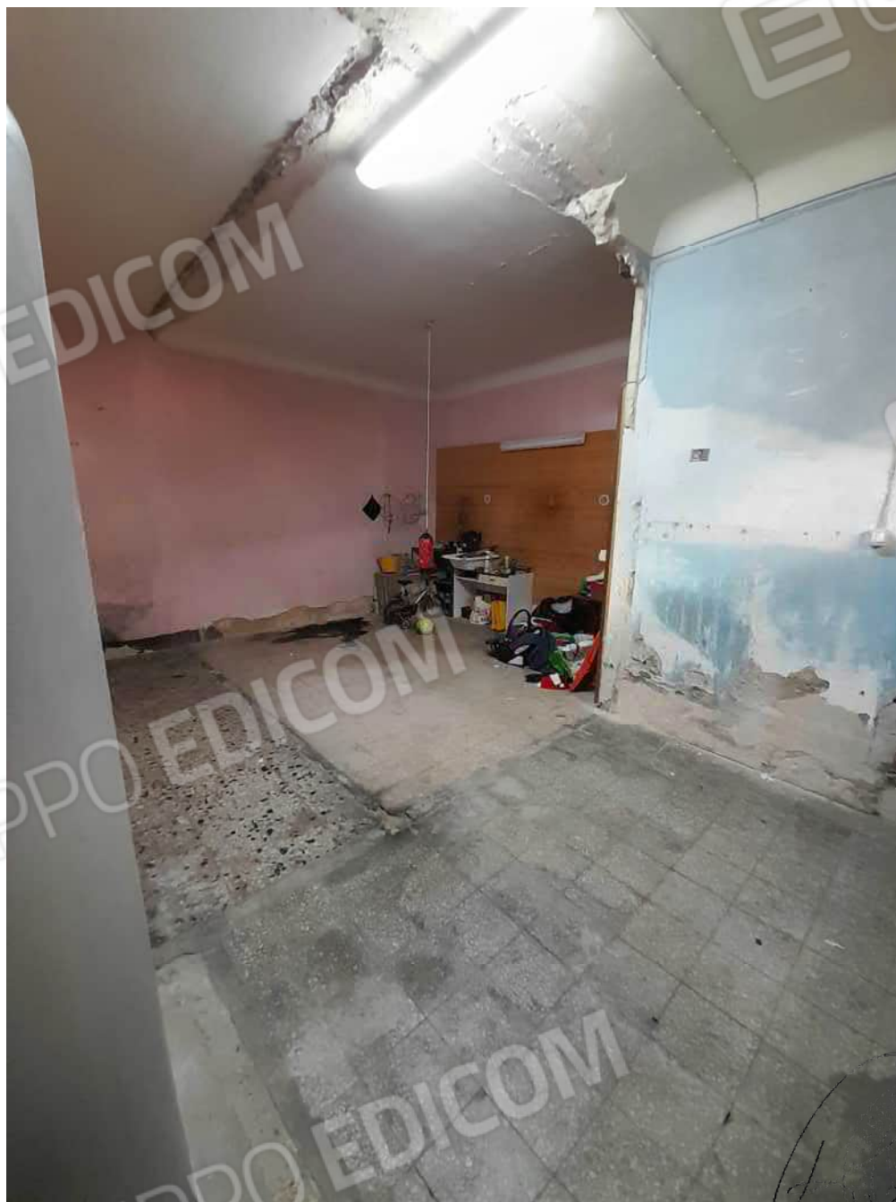
Foto n°15 - Vista interna dell'autorimessa
