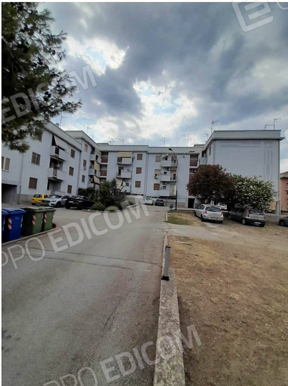
Foto n°1 - Vista del complesso edilizio denominato Condominio Jonio
