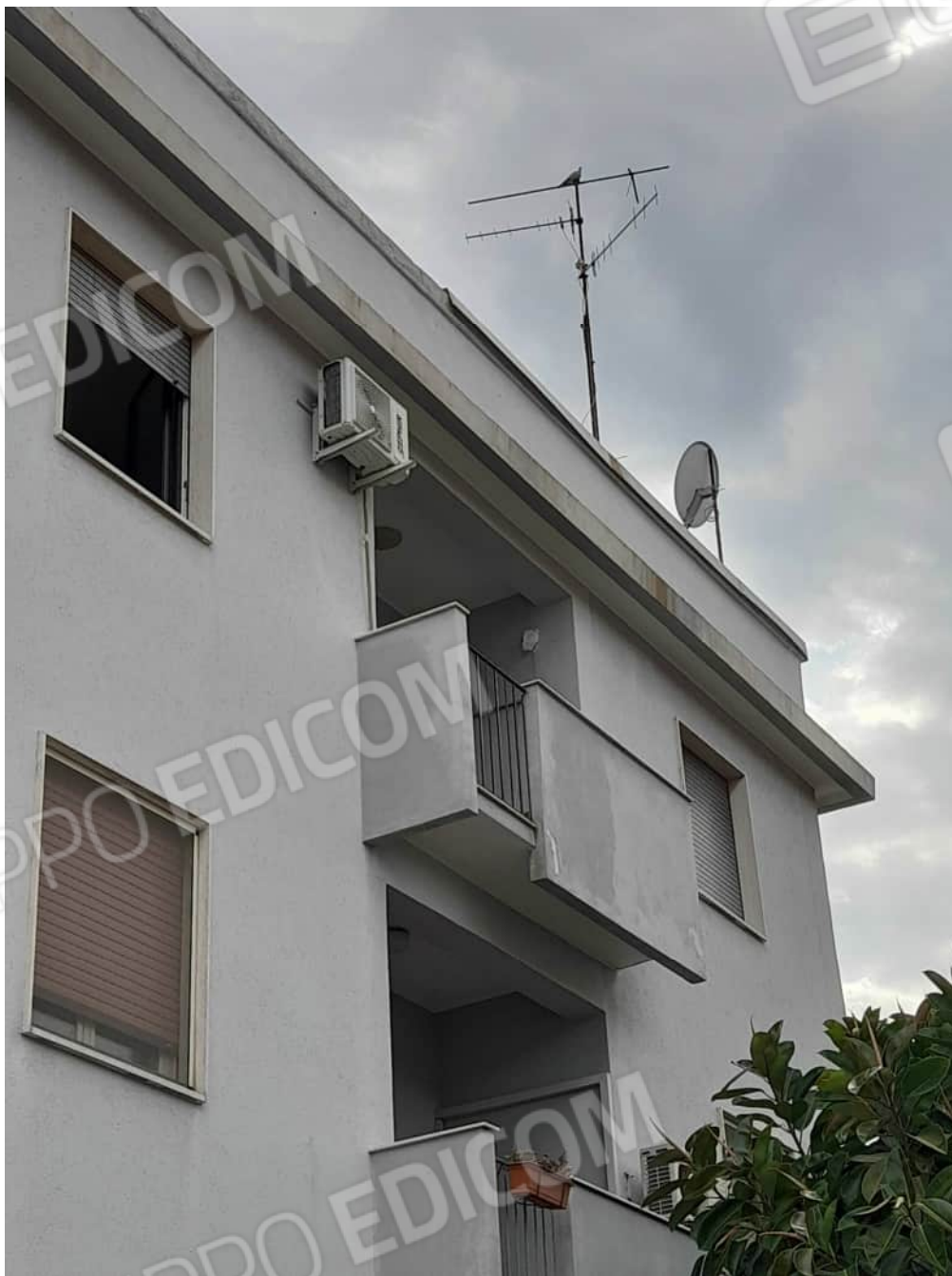
Foto n°3 - Vista del prospetto Nord
