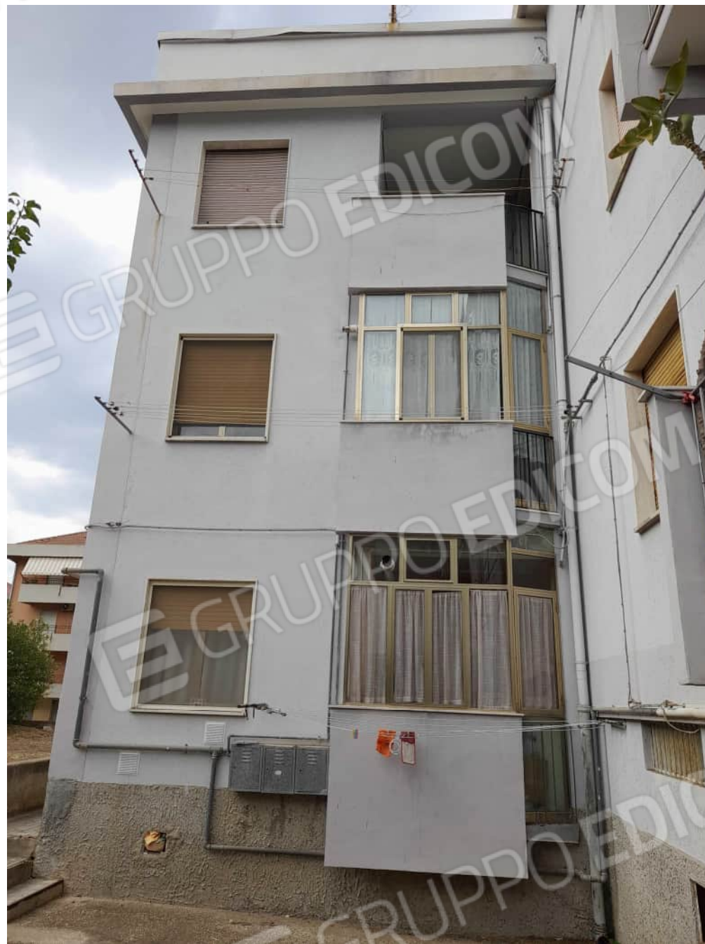
Foto n°4 - Vista del prospetto Sud
