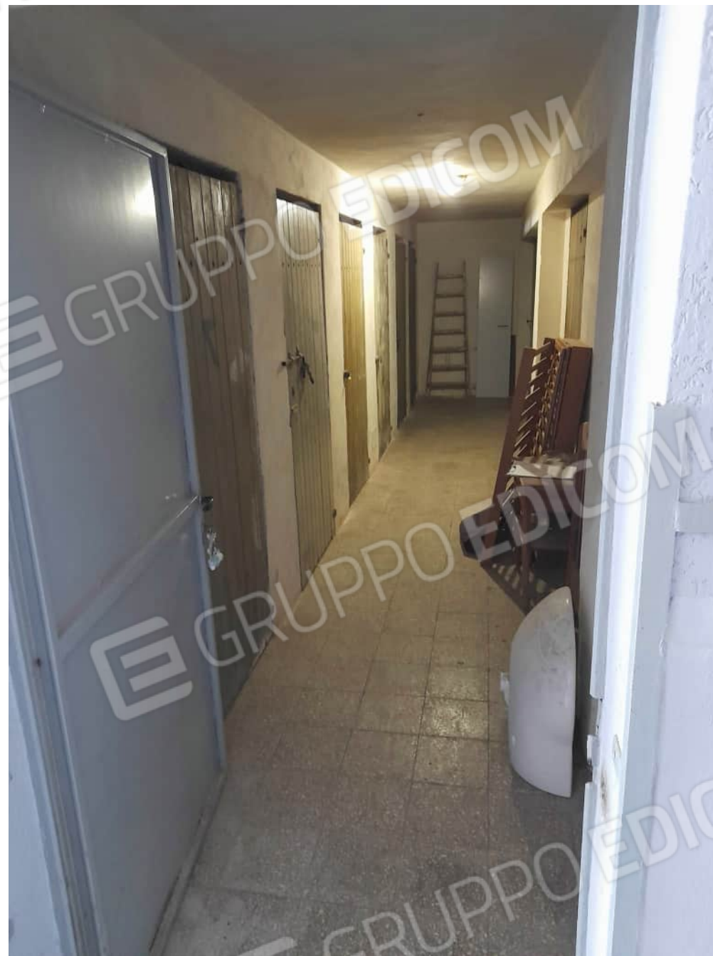
Foto n°18 - Vista interna del corridoio comune delle cantine
