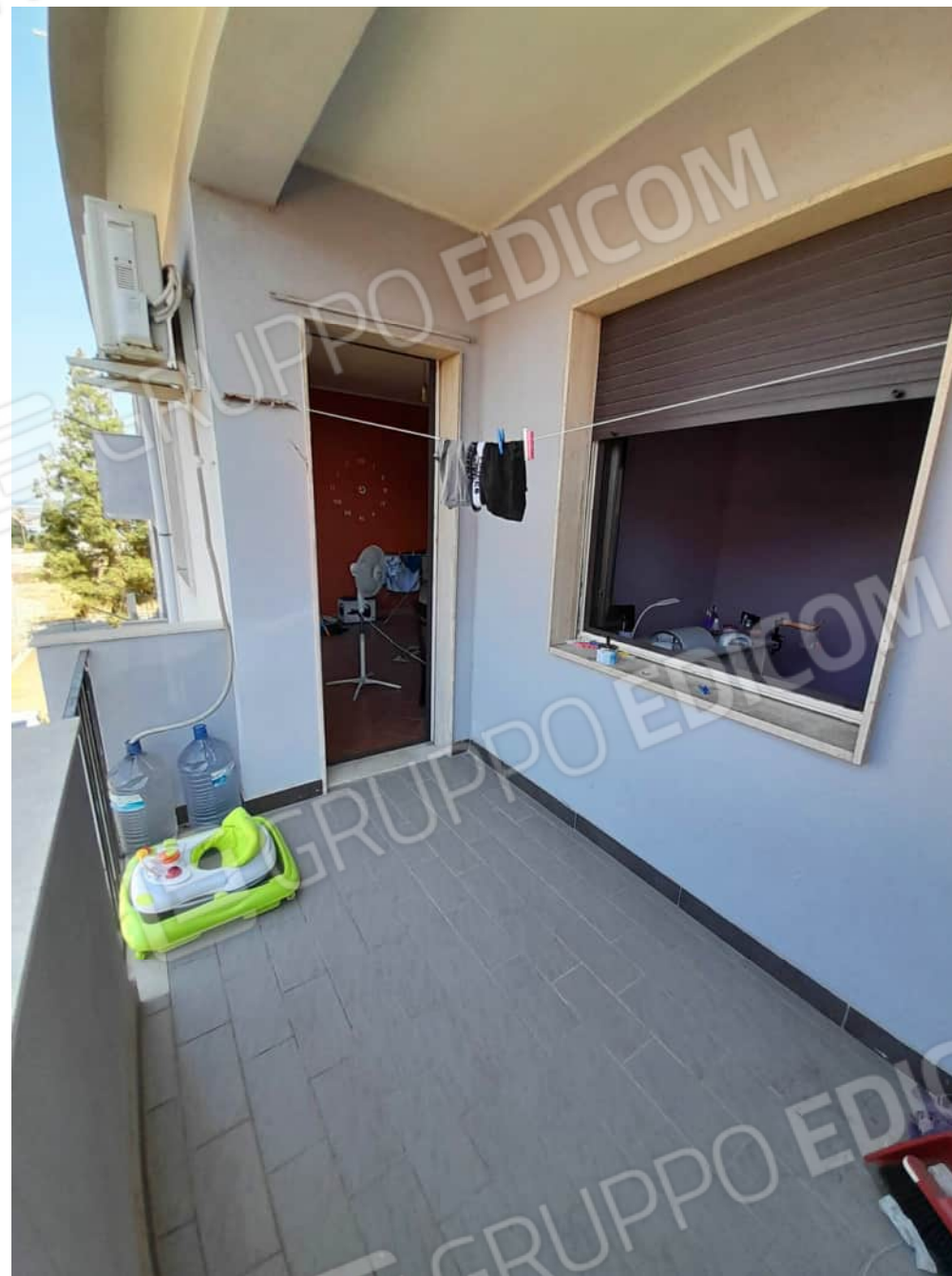
Foto n°16 - Vista della veranda coperta sul prospetto Nord
