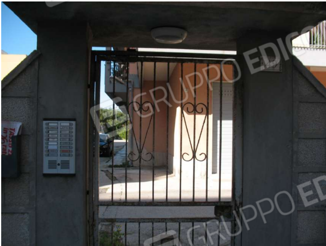
Foto 3 - Cancelli pedonale di accesso al Condominio "Primavera"
