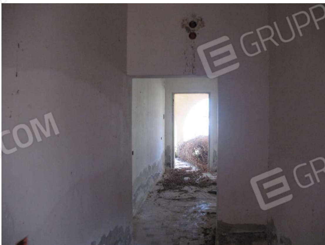
Foto 6 - Disimpegno (Vista verso l'ingresso)
