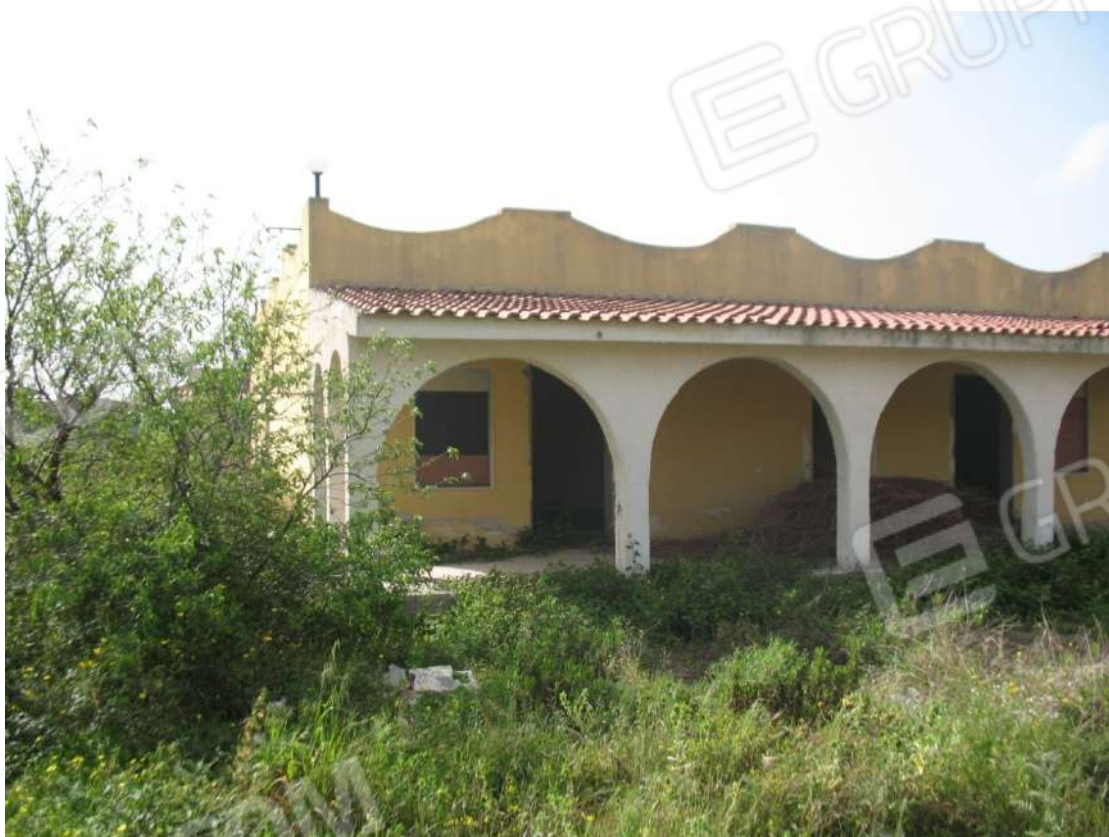
Foto 2 - Prospetto principale (Lato Nord)
