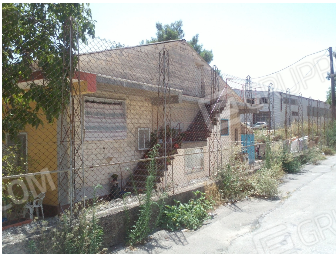
Foto 10. Muratura esterna senza intonaco al sub 8
