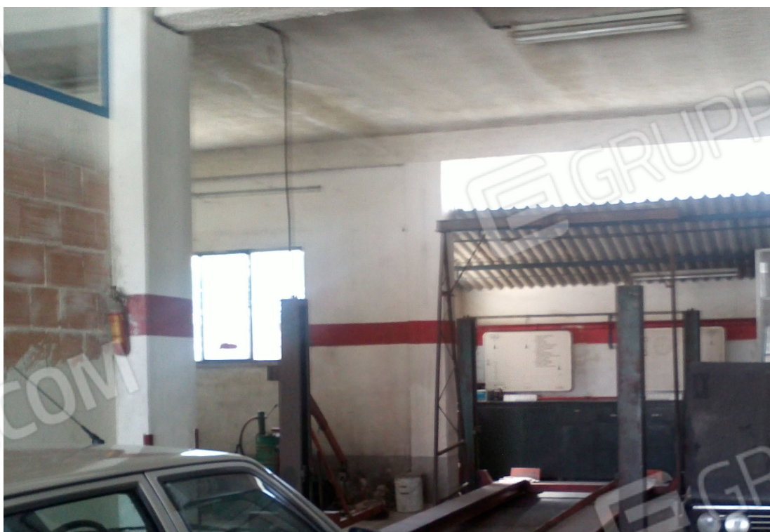
Foto 02. Struttura portante in pilastri di cemento armato, con muratura di confine in blocchi di calcare e tramezzi interni in laterizio forato.
