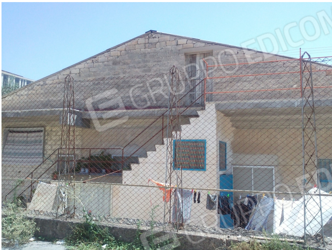
Foto 03. Tetto a due falde.
