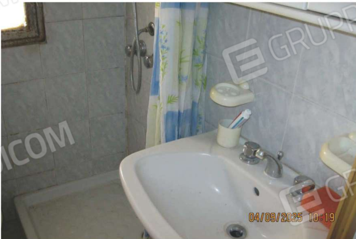
Foto 37: il bagno al secondo piano
