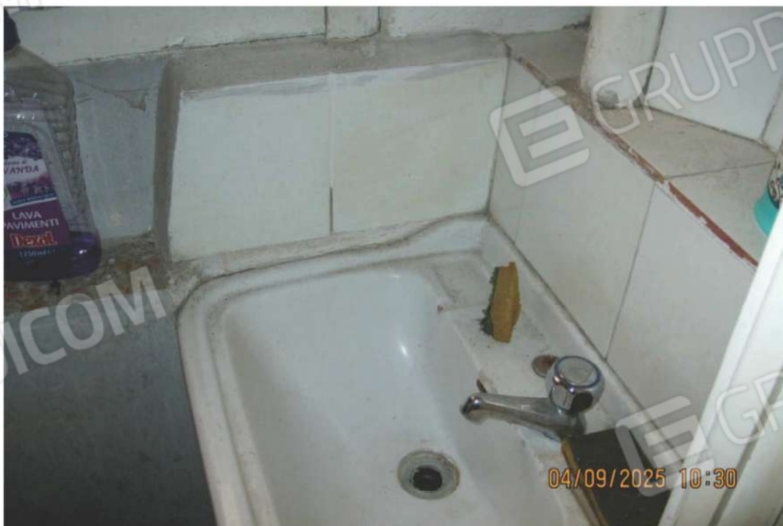
Foto 29: il bagno al primo piano
