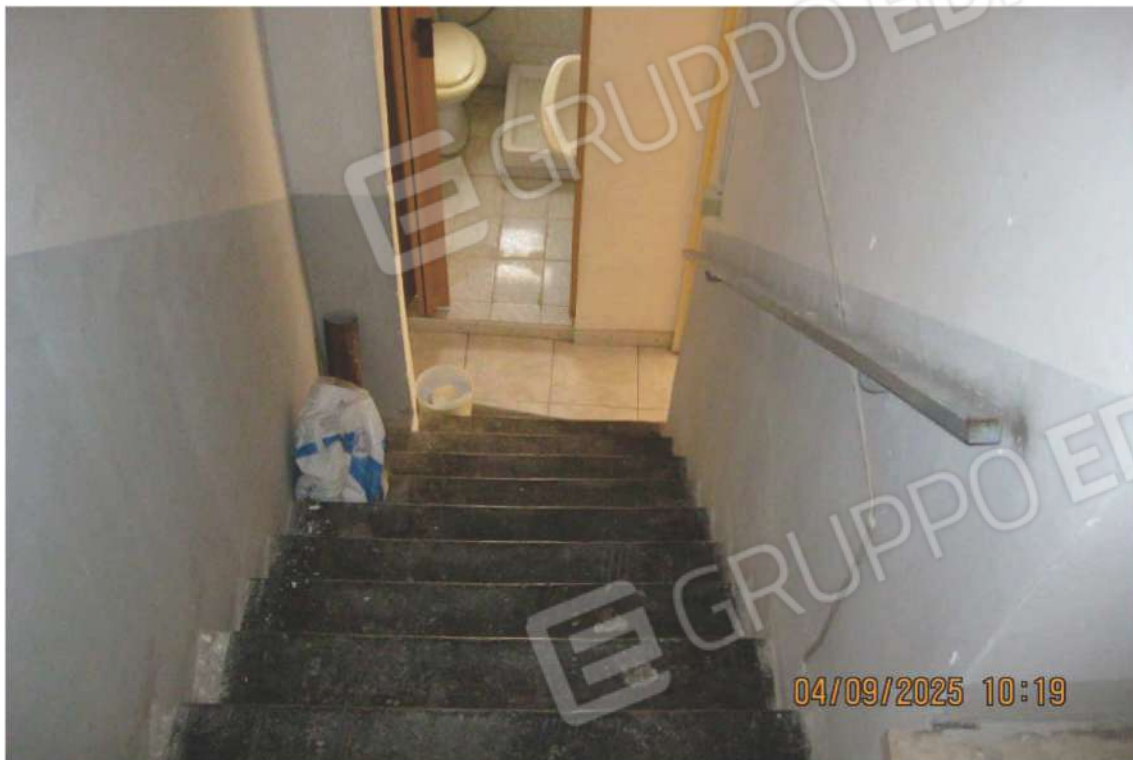
Foto 40: la scala di accesso al terzo piano, fotografata dal terzo piano
