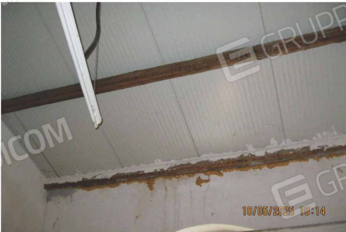
Foto 6: particolare della copertura
