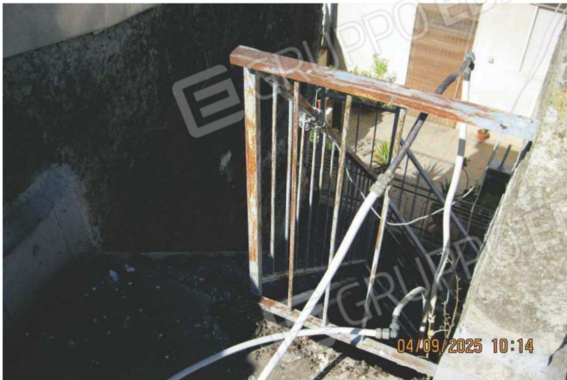
Foto 46: la scala di accesso al lastrico solare fotografata dal lastrico solare
