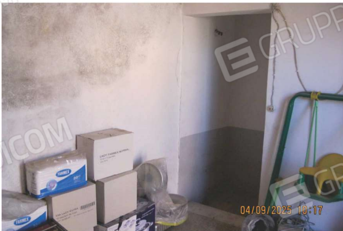
Foto 41: il vano al terzo piano
