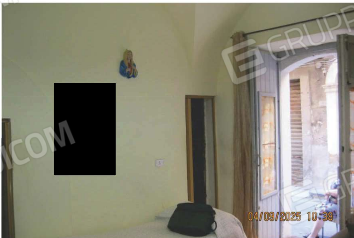
Foto 21: il vano al piano terra
