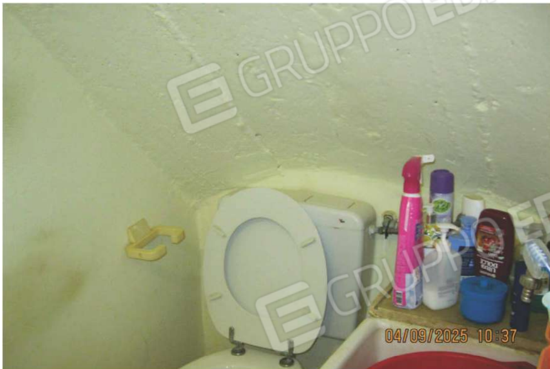
Foto 24: il bagno nel vano sottoscala del piano terra
