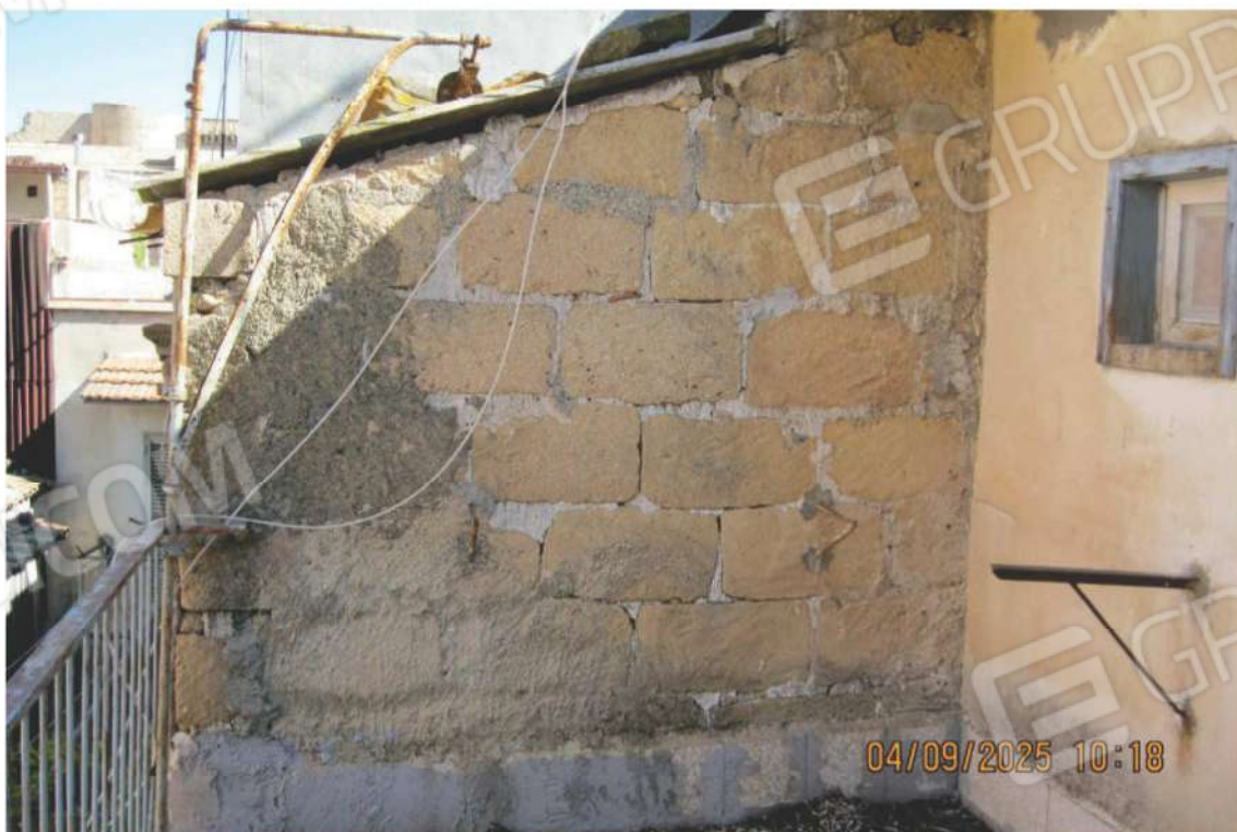
Foto 45: altra rappresentazione fotografica del terrazzino al terzo piano
