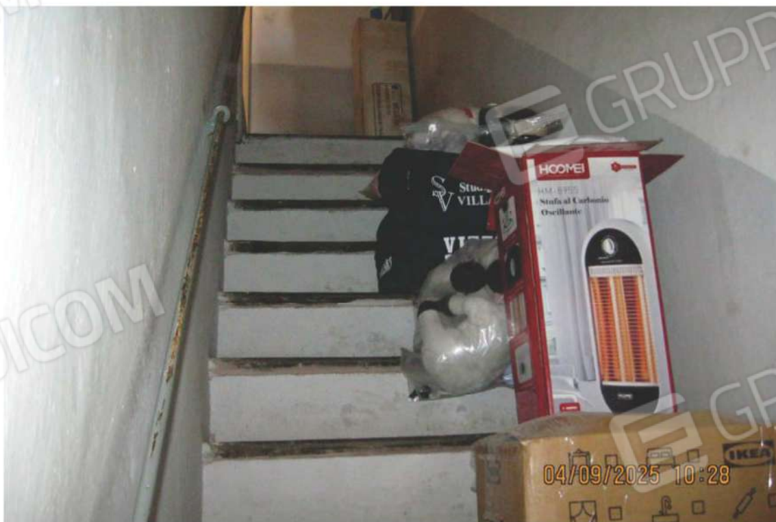
Foto 31: la scala di accesso al secondo piano
