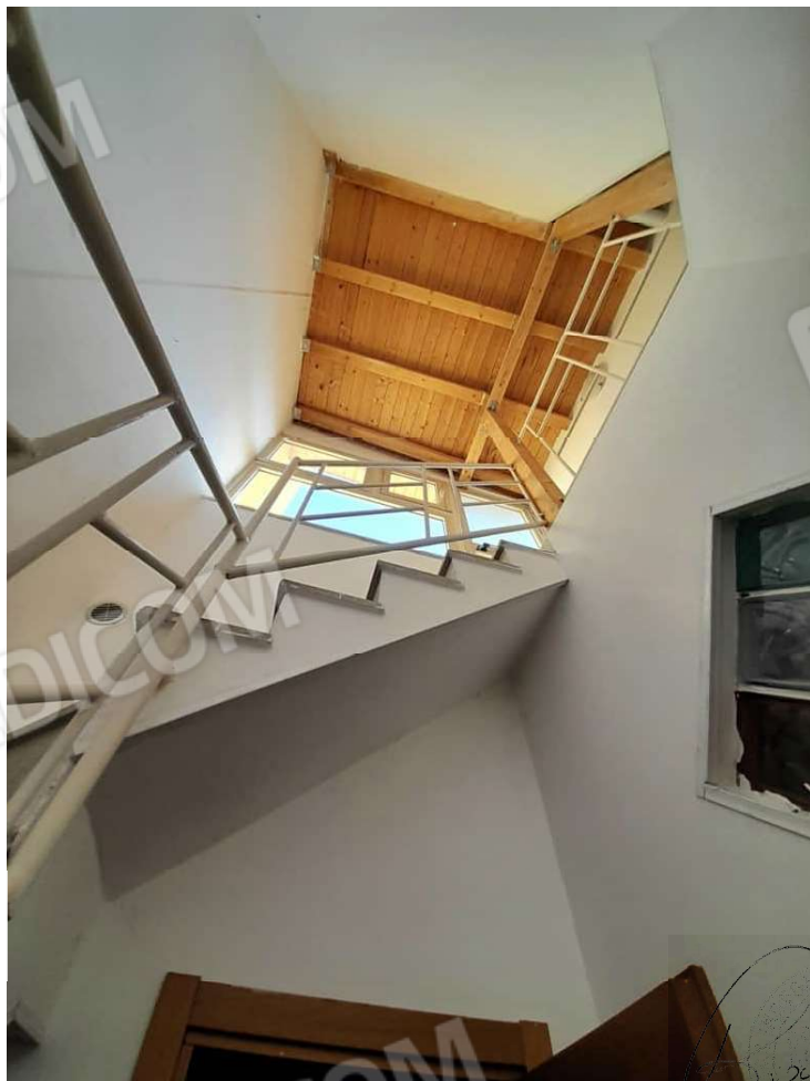
Foto n°11 - Vista interna del pozzo luce
