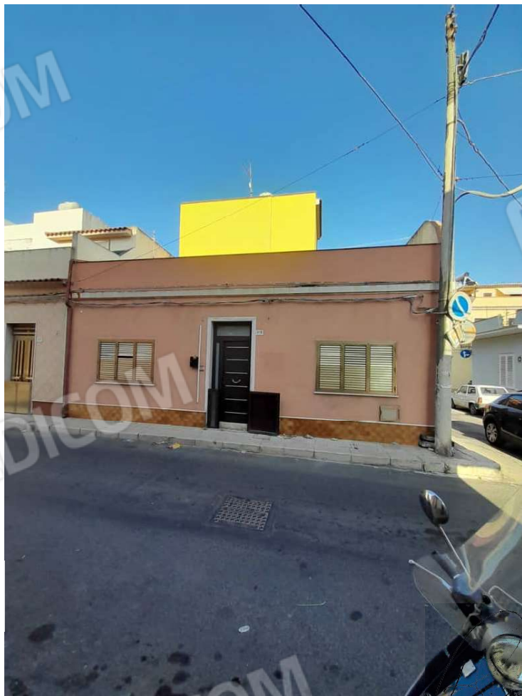
Foto n°1 - Vista del prospetto su via Nizza
