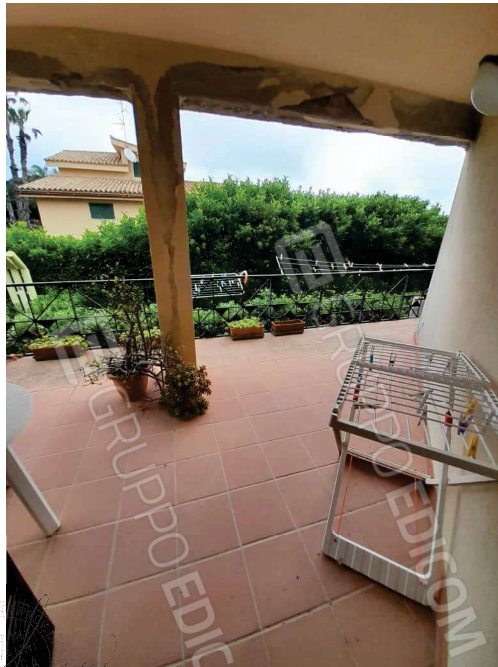
Foto n°8 - Particolare della veranda coperta con accesso dal disimpegno
