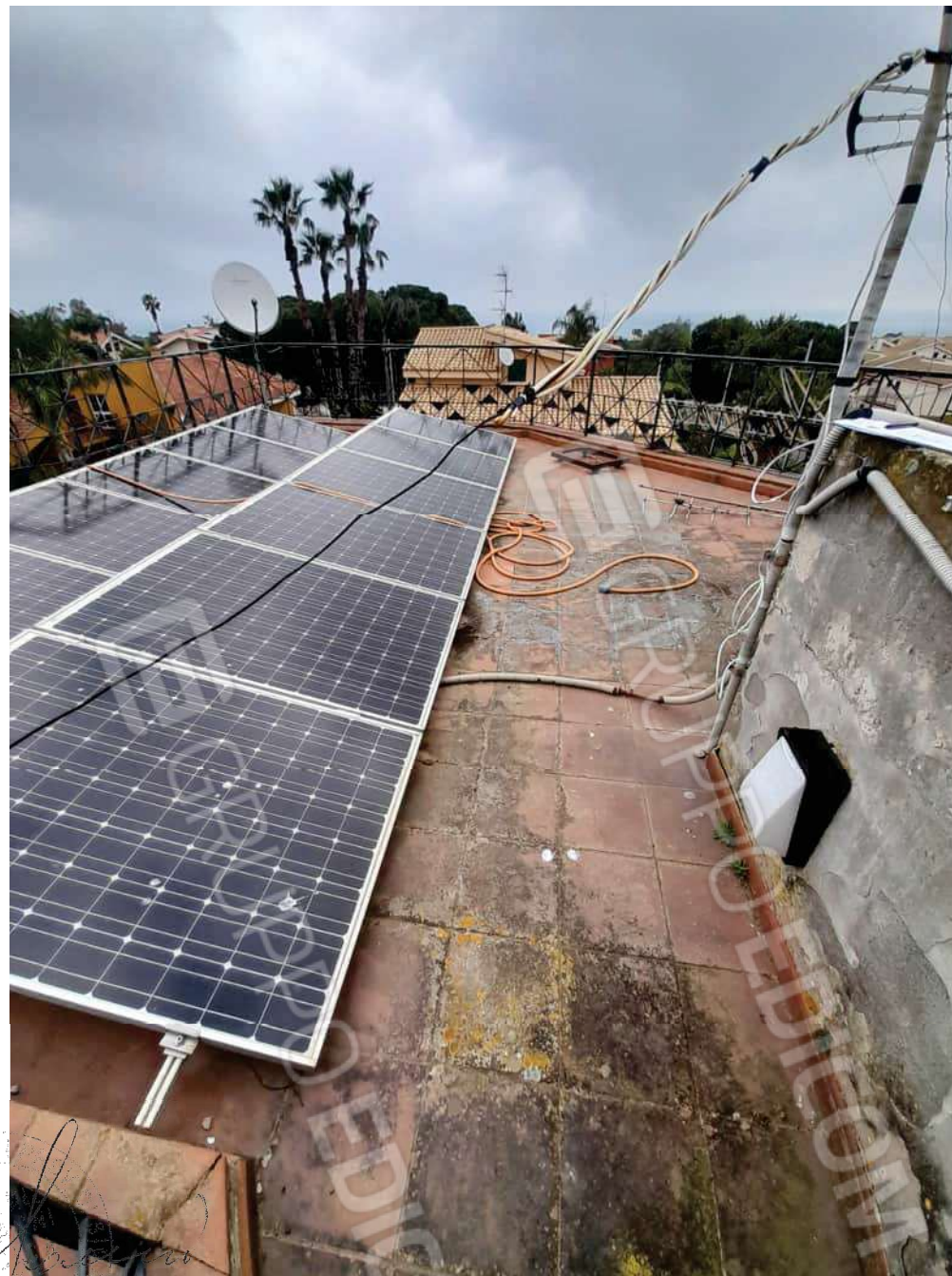
Foto n°30 - Vista della terrazza di copertura
