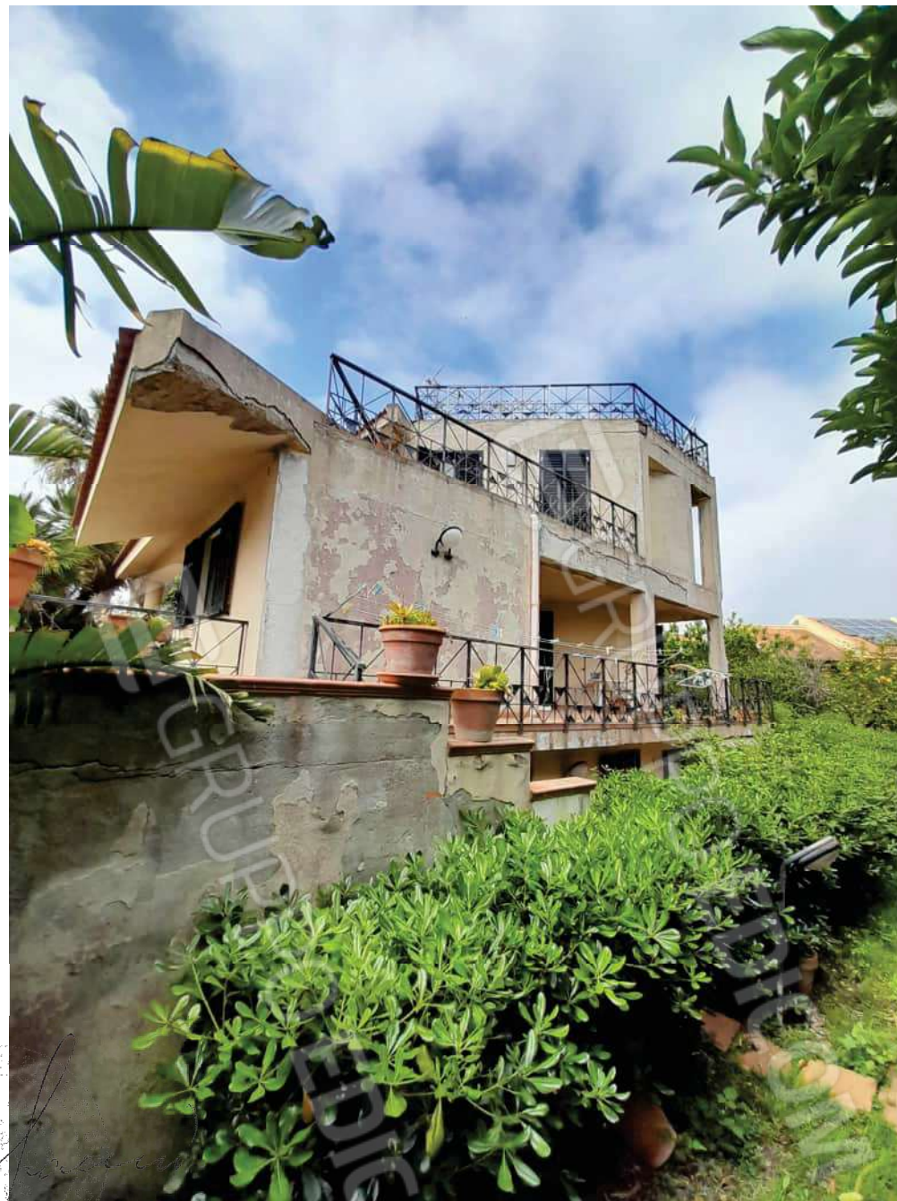
Foto n°4 - Prospetto di Nord-Est
