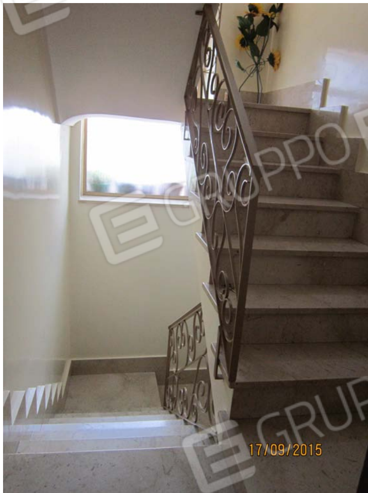
Foto n° 7 – Appartamento a Buccheri – Vano scala
