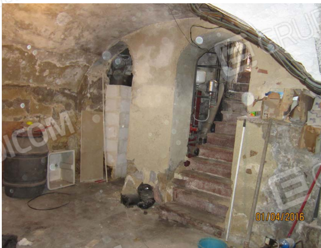
Foto n° 6 – Piano seminterrato Edificio a Bucchini – Dispensa
