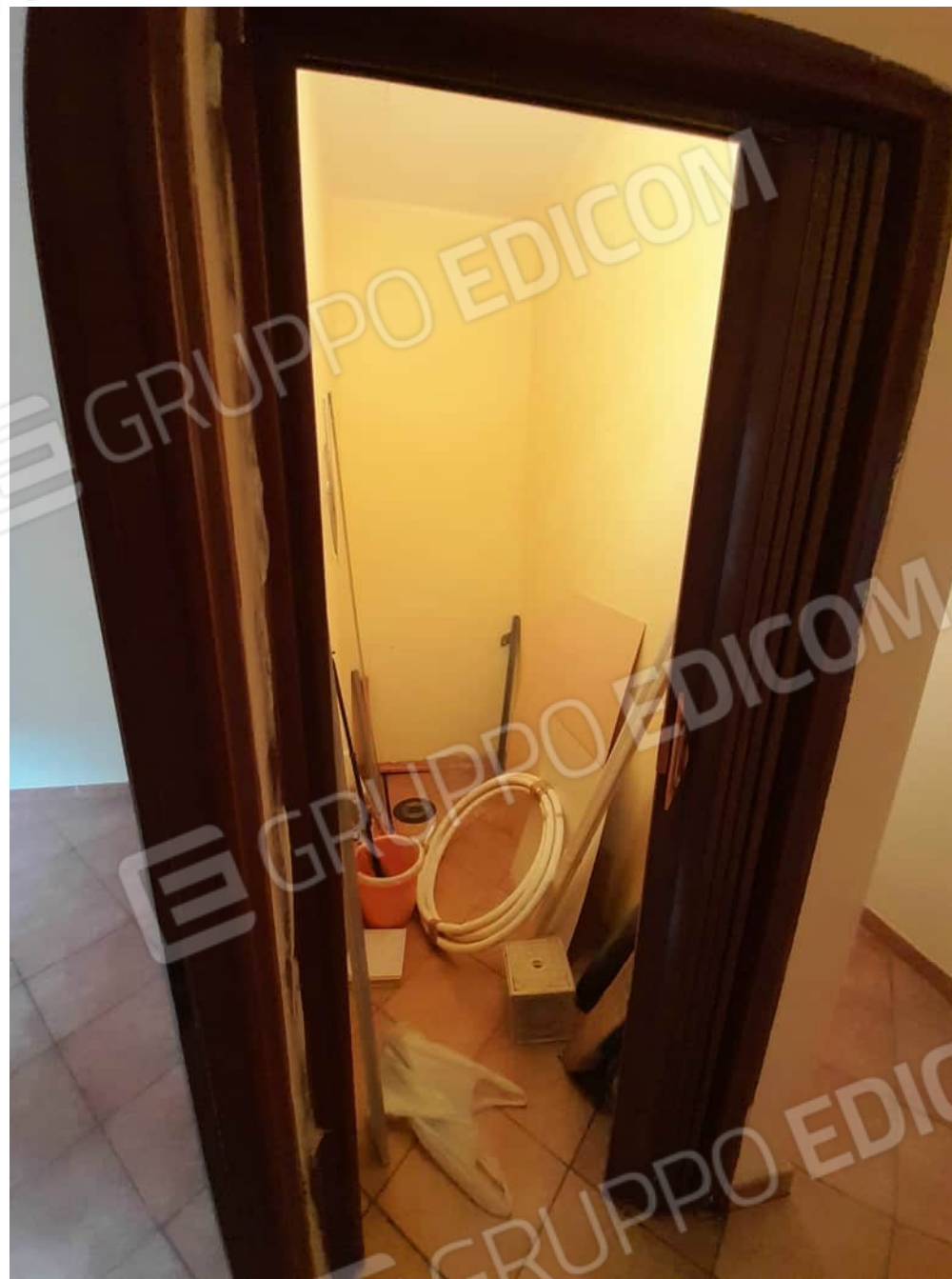
Foto n°10 - Vista interna del ripostiglio
