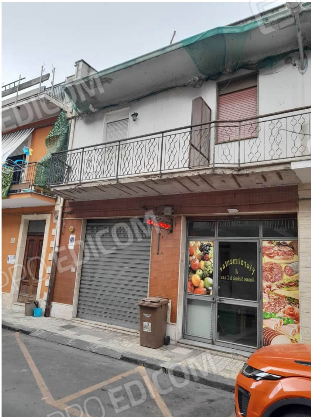
Foto n°1 - Vista del prospetto su via Ariosto
