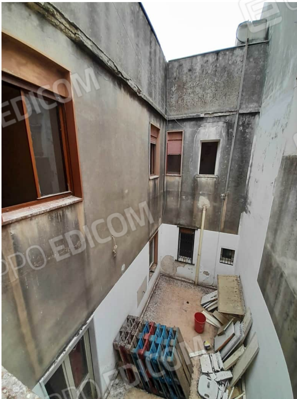
Foto n°3 - Vista dei prospetti sul pozzo luce
