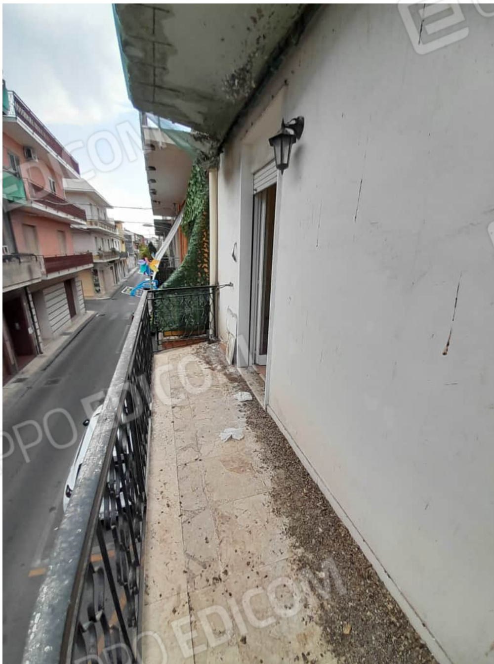
Foto n°13 - Vista del balcone di pertinenza
