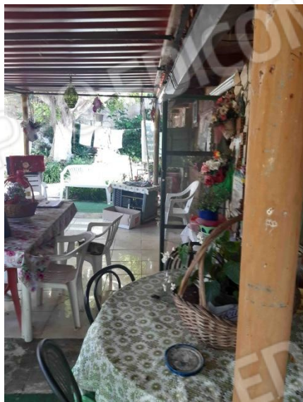
Foto 18– Tettoia antistante il fabbricato
