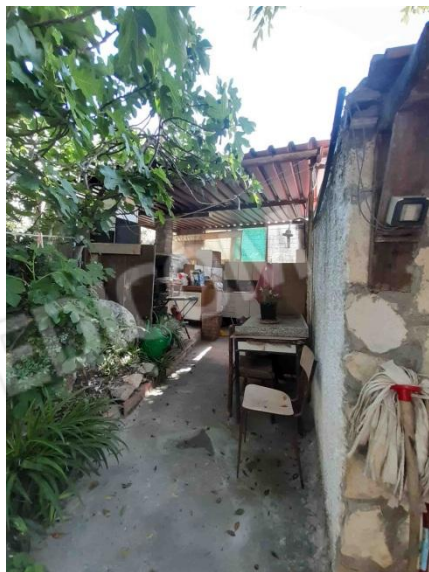
Foto 14 – Tettoia adiacente al Fabbricato
