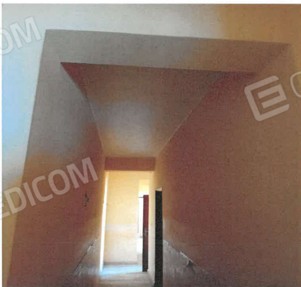
Foto n.ro 38 : dettagli travi in c.a. corridoio
