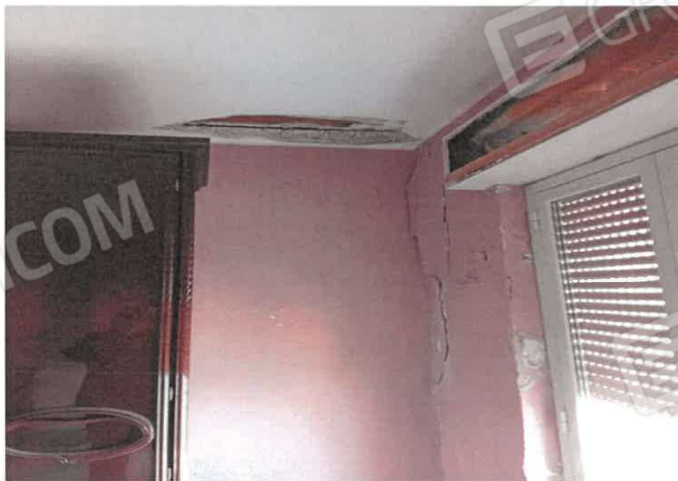
Foto n.ro 15 . dettagli salone , confine nord
