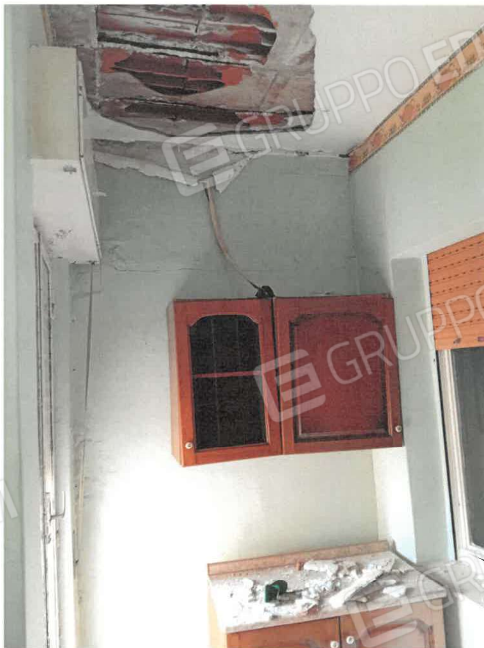
Foto n.ro 26 : distacchi intonaco per infiltrazioni dal terrazzo condominiale
