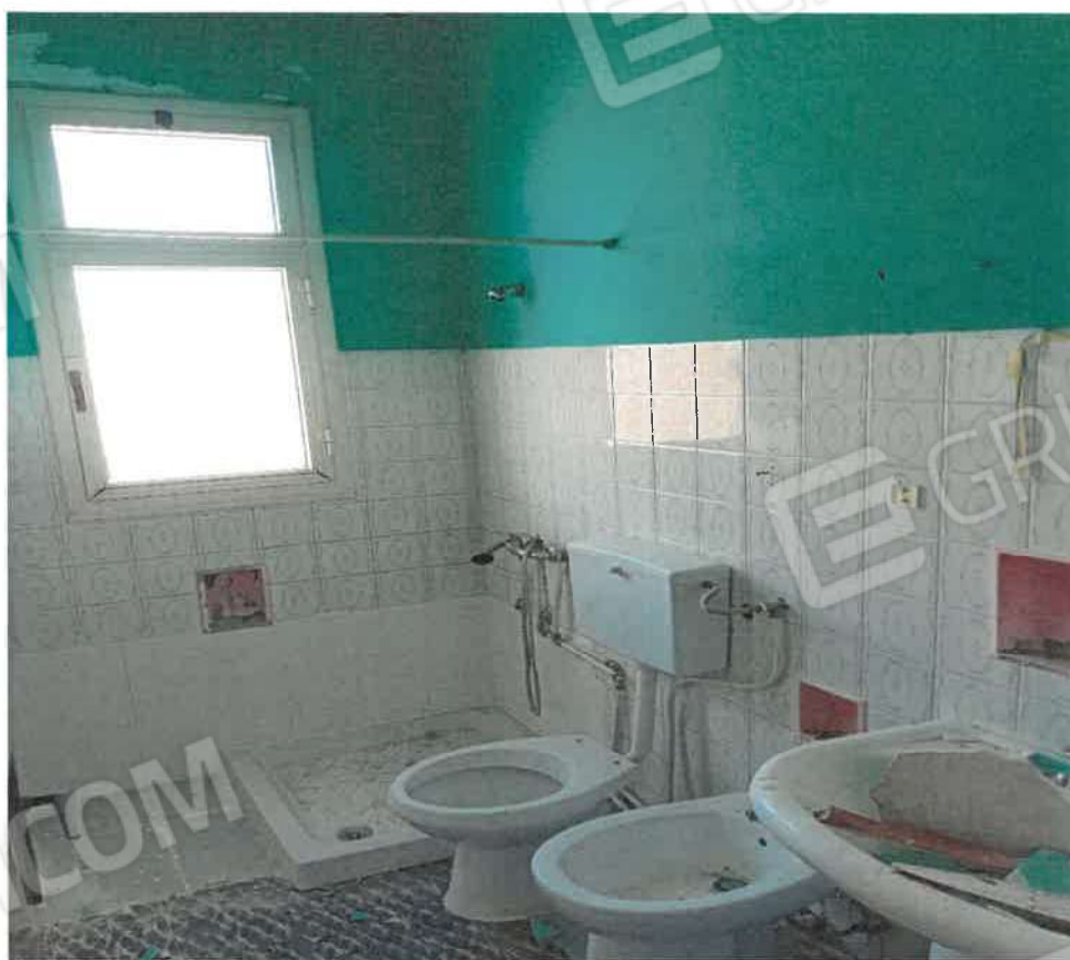
Foto n.ro 30 : il locale bagno
