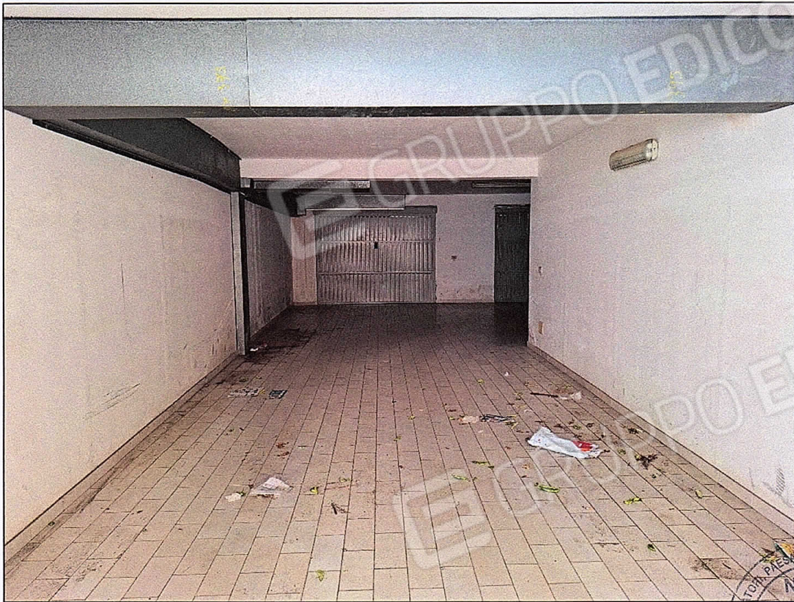
Foto 17_Piano seminterrato_Vista box auto dalla corsia carrabile
