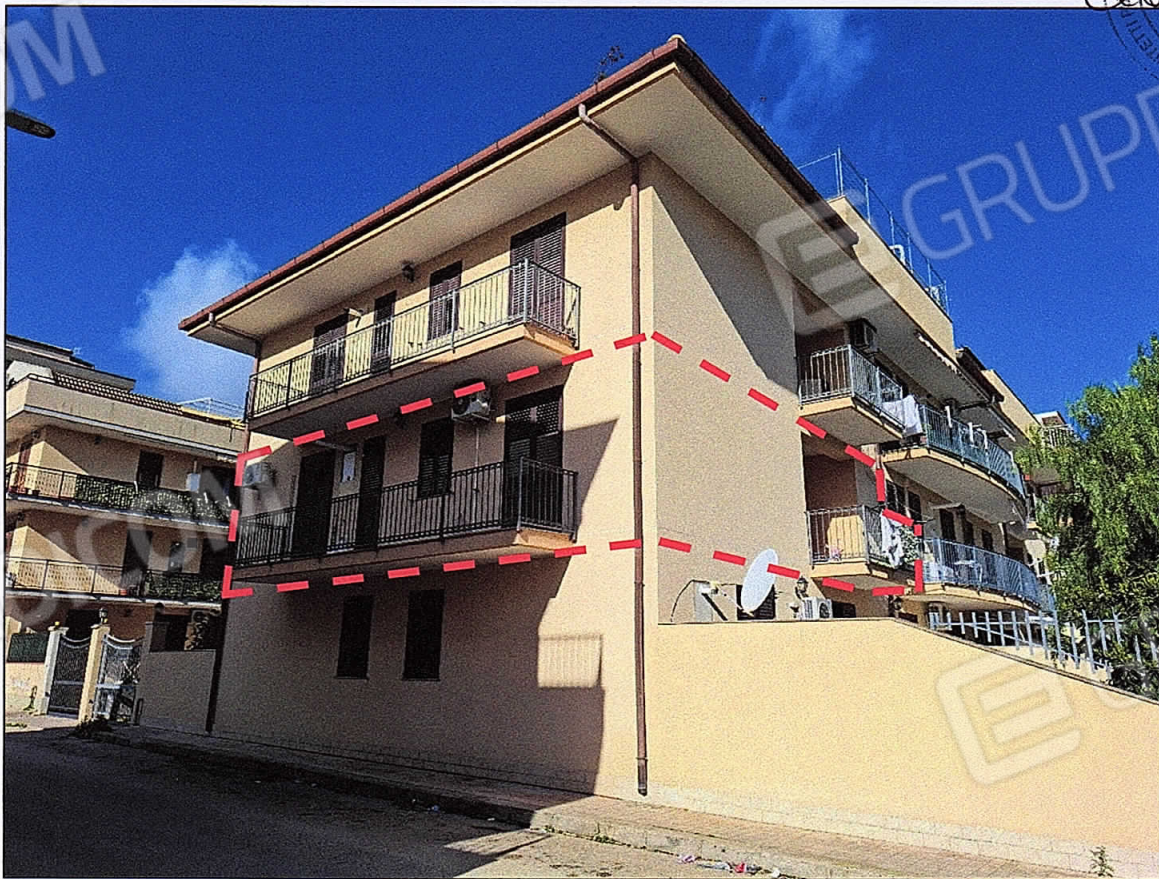
Foto 2_Il condominio_Via dei Platani_Vista esterna con individuazione dell'appartamento
