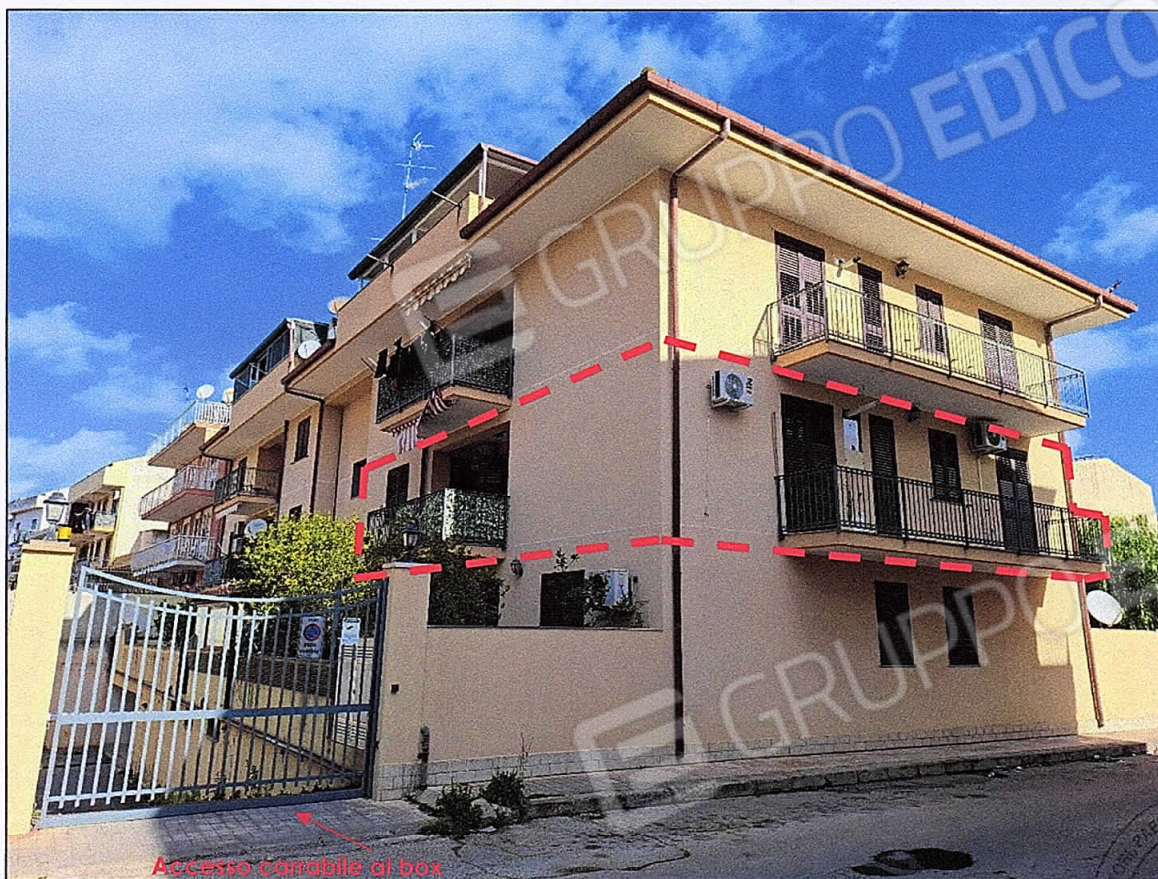
Foto 3_Il condominio_Via dei Platani_Vista esterna con individuazione dell'appartamento
