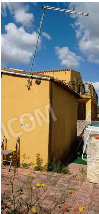
foto n.15 - prospetto nord locale di sgombero
