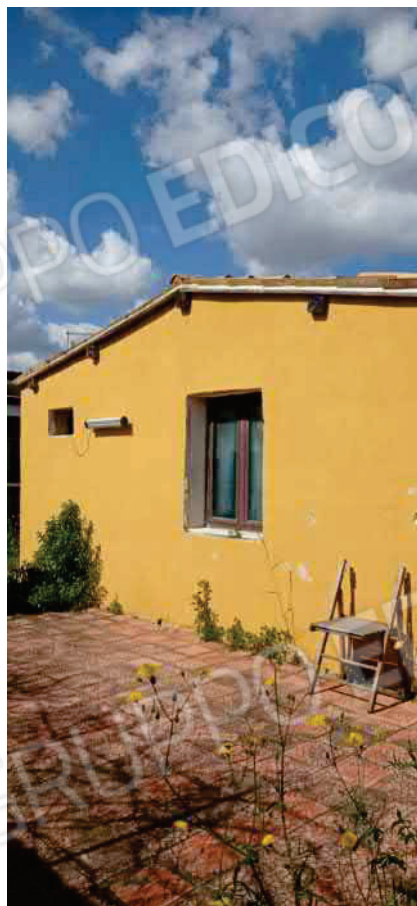
foto n.14 - prospetto est locale di sgombero
