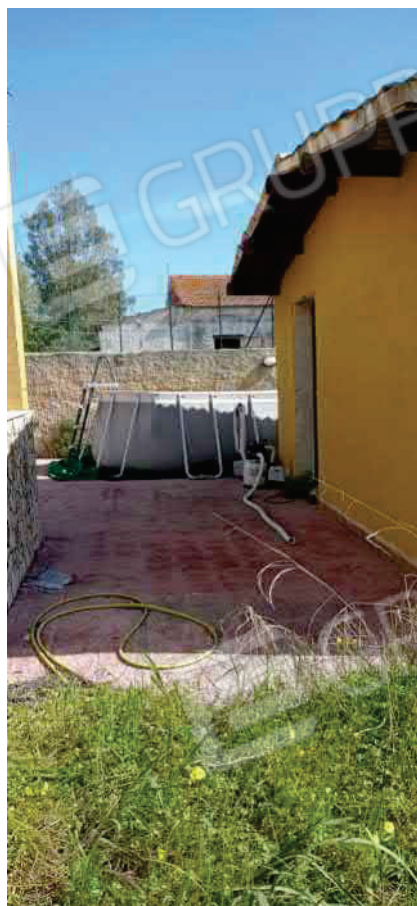
foto n.16 - prospetto ovest locale di sgombero
