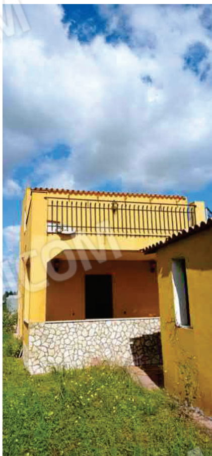
foto n.11 - prospetto est abitazione
