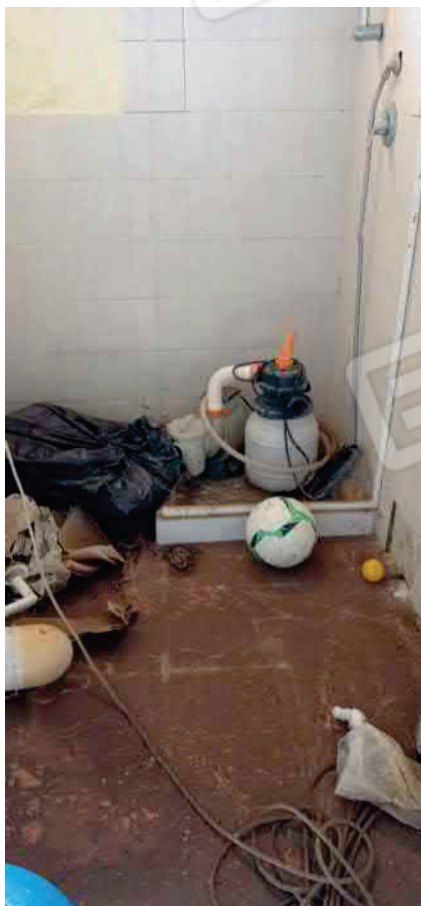
foto n 9 - wc piano terra
