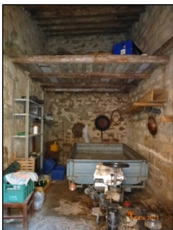
Foto 15 Interno Vano Magazzino Con ingresso da Via Nuovo Bevaio 30
