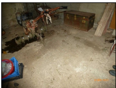
Foto n. 21 Particolare battuto cementizio di pavimentazione
