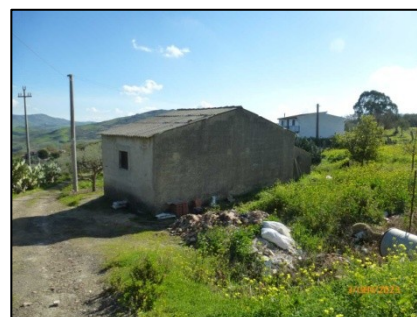
Foto 30 Porzione attorno Magazzino descritto al punto a) p.lla 1066 sub 2
