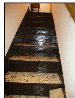
Foto n. 10 Rampa per il Piano 3°
