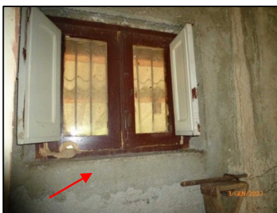
Foto n. 22 Sostituzione porta finestra con finestra Lato Pollaio
