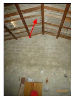
Foto 19 Altezza minima interna 3 m Evidenziata in rosso la copertura con pannelli in cemento-amianto
