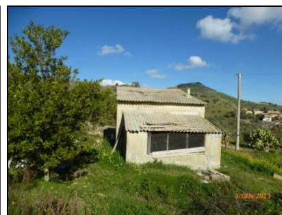
Foto 27 Prospetto Lato Sud (pollaio)
