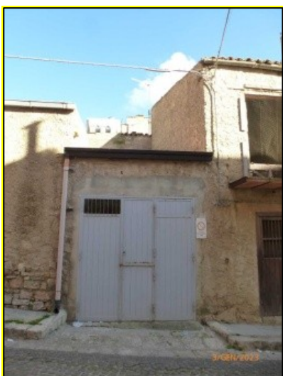
Foto 17 Prospetto Lato S-W- Accesso carrabile da Via Nuovo Bevaio 30
