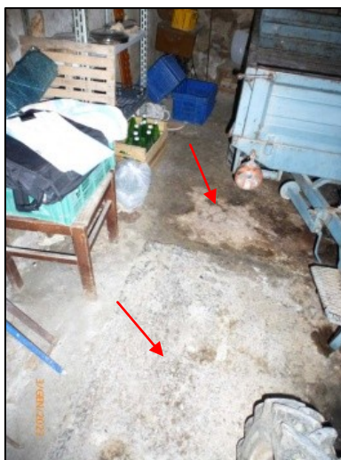
Foto 16 Particolare pavimentazione interna la freccia in basso indica zona con battuto cementizio, freccia in alto indica zona priva di pavimentazione
