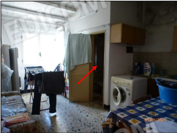
Foto 11 Lavanderia a Piano 3° Evidenziato in rosso il W.C. dotato di tutti i pezzi sanitari
