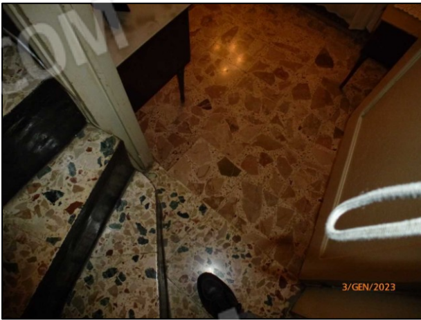
Foto n. 9 Ingresso Rampa per il Piano 3°
