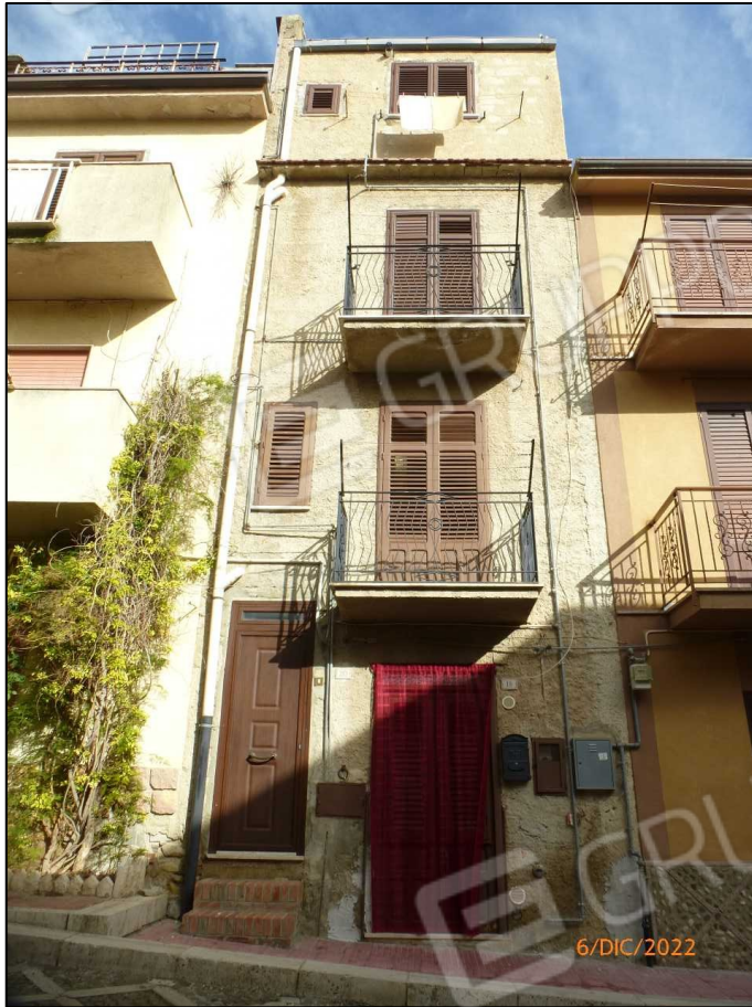
Prospetto ingresso lato S-W, immobile pignorato in Via Nuova civ. 18-20 Comune di Roccapalumba, Fig. 7 p.lla 1005 sub 2.
