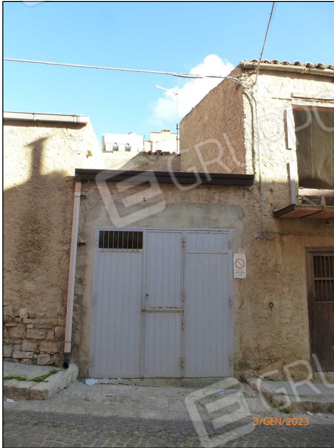
Prospetto ingresso lato S-W, immobile pignorato in Via Nuovo Bevaio civ. 30 Comune di Roccapalumba, Fig. 7 p.lla 1667 sub 2.
