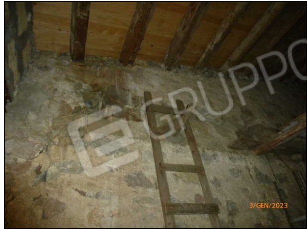
Foto 2 Scala in legno per accesso alla zona soppalcata in legno.
