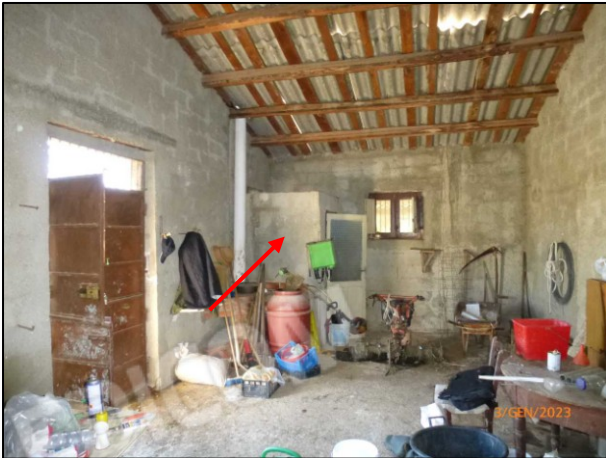
Foto 4 Magazzino e evidenziato in rosso W.C. interno
