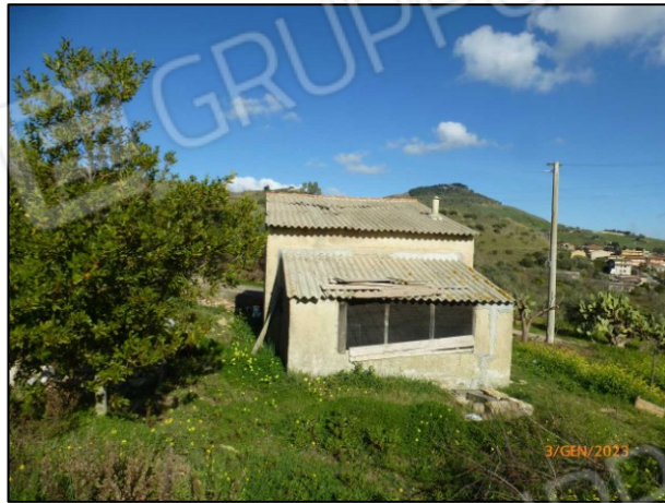
Foto 3 Prospetto Lato Sud (pollaio)
