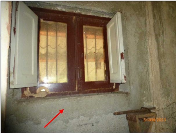
Foto 8 Sostituzione porta finestra con finestra Lato Pollaio Evidenziata in rosso l'ex vano porta
